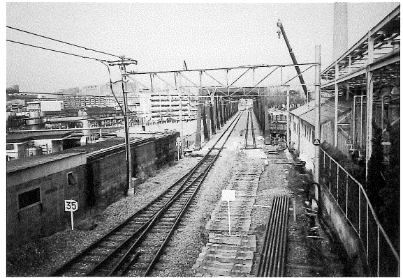
■奈良線鴨川橋梁
