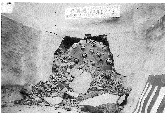
■ロックライナー併用改良オープン型TBMによる施工
