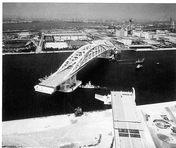
■夢舞大橋の建設
