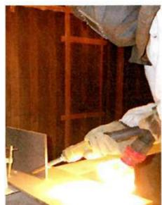
2. PPP (Portable Pneumatic needle-Peening) を用いたき裂閉口処理法
