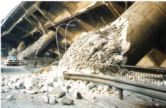
・コンクリートの破壊面に沿い鉄筋のクビレが分布・北東から南西方向に割れが発達・北西部に落下の痕跡
