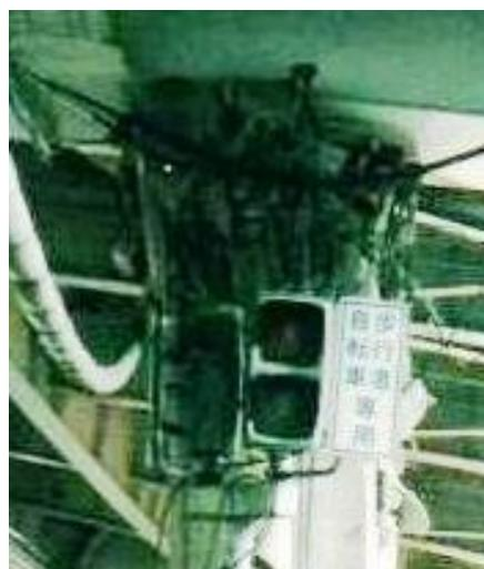
図 2.26 P459 海側柱頭部の破壊状況<sup>47)</sup>
