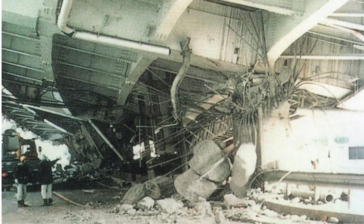
奥にある P457, P456 の海側柱は P458 と 3 基連続して壊滅的に破壊(西より見る)
