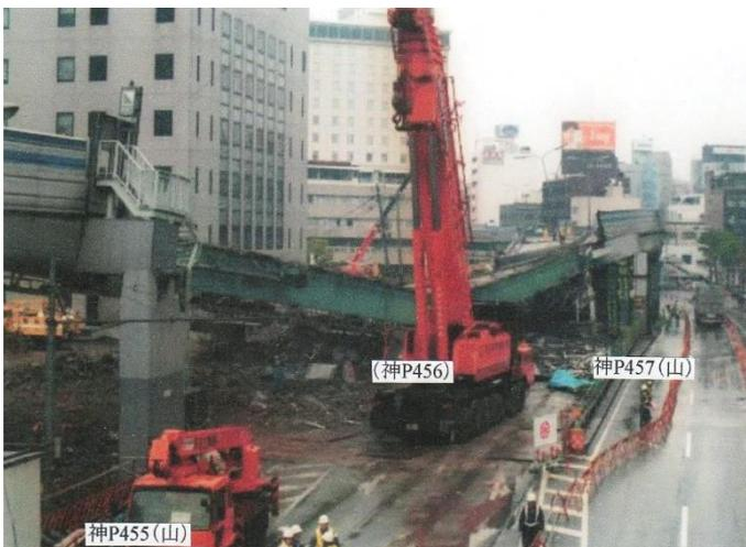
図の中央部の窪んだ部分で P456 橋脚が破壊
