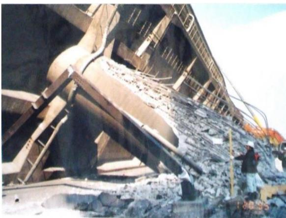
図 2.32 倒壊橋脚の代表例 P132(西面)<sup>48)</sup>
