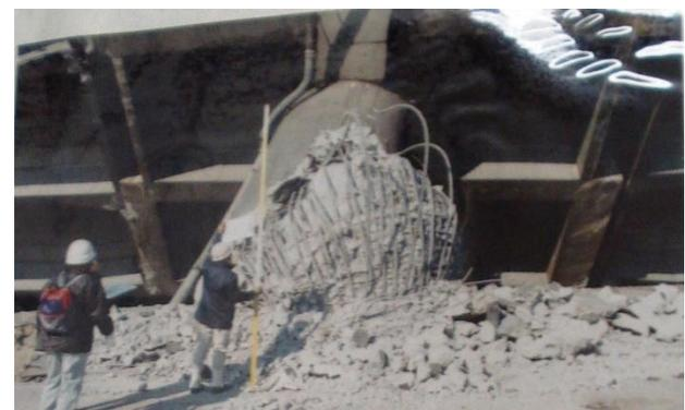
図 2.41 神 P140(南面)<sup>48)</sup>・倒壊方向外の割れ発達
