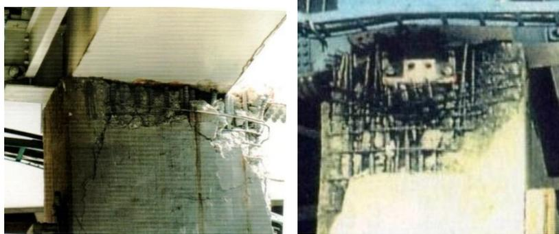
(a) 北面の損傷状況 (b) 南面の破壊状況
