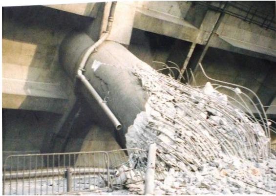
柱の南西面に大きな斜め割れ塊
