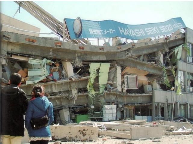
図 2.45 RC 3階建社屋の崩壊(須賀川市・2011)<sup>53)</sup>
