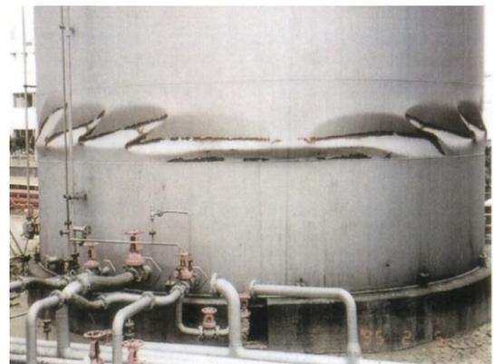
図 2.47 タンクのダイヤモンド座屈<sup>55)</sup>
