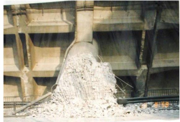
柱基部は北西側に着地，北東から南西方向に割れが発達
