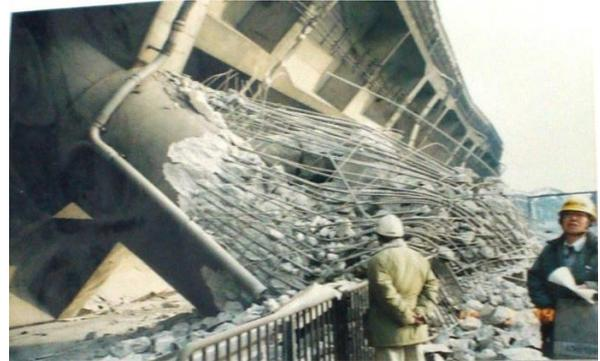
・北東から南西方向に割れが発達・北西部に落下の痕跡
