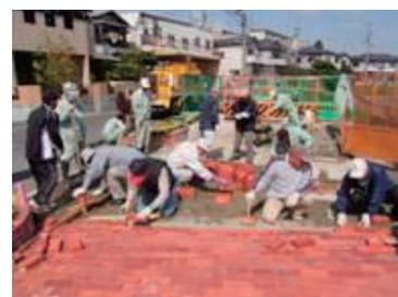
アシュレン（下水道泥焼却灰レンガ）を用いた花壇や舗装の協働作業
