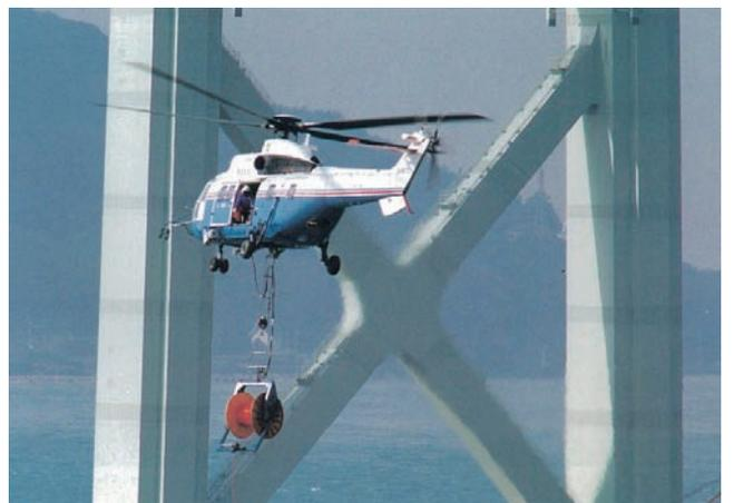
図-3 ヘリコプターによるパイロットロープ架設
