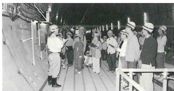
■いろは呑龍トンネル坑内で工事の説明を聞く参加者
