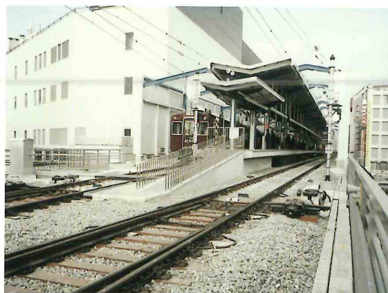
非常時に車いす利用のお客様も利用可能な 避難用スロープ（ホーム先端部）
