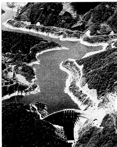
■ダム・砂防 真名川ダム
