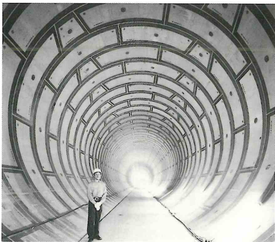
■寝屋川北部地下河川事業 ～日本初の一次履行のみによる内圧対応型トンネルの築造～
