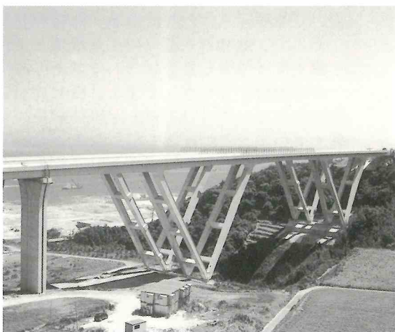
■灘川橋（V脚ラーメン橋）
