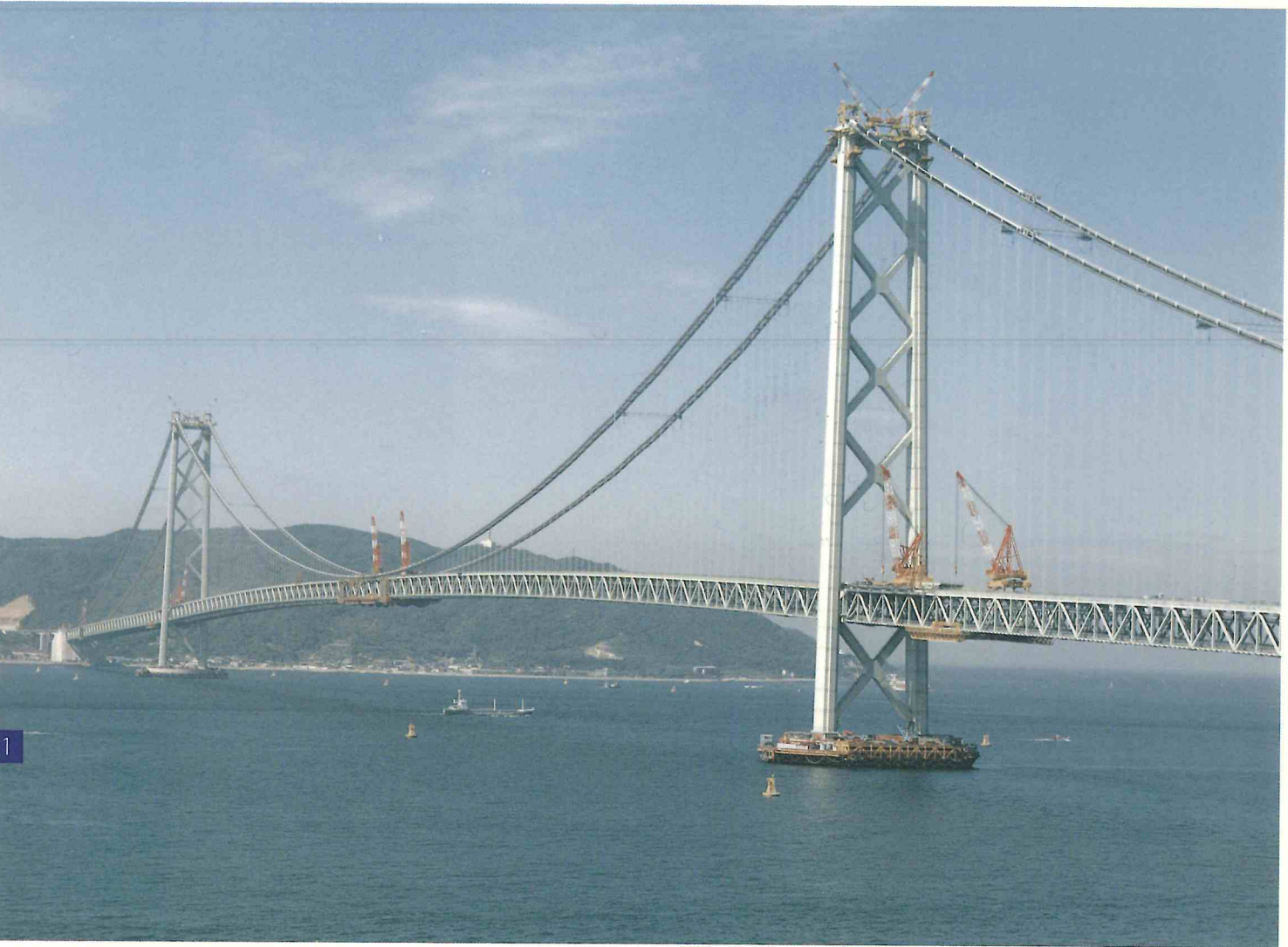
1996.8.11 明石海峡大橋補剛トラスの連結完了時の全景 (写真提供：本州四国連絡橋公団)
