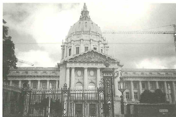
補強工事中のサンフランシスコ市庁舎
