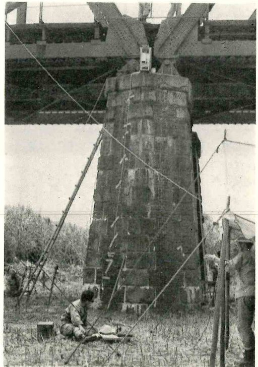
宇治川橋梁測定対象橋脚
