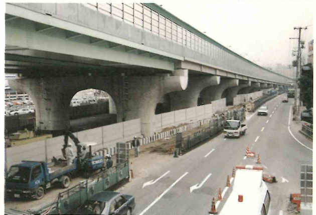
国道43号岩屋高架橋の復旧完了状況 (写真提供：建設省兵庫国道工事事務所)
