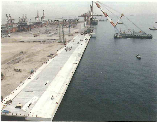
完成間近な仮設コンテナ棧橋(8頁参照) 写真提供: 運輸省第三港湾建設局
