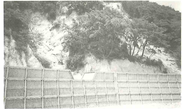
鋼製枠ダム工(宝塚市逆瀬台)
