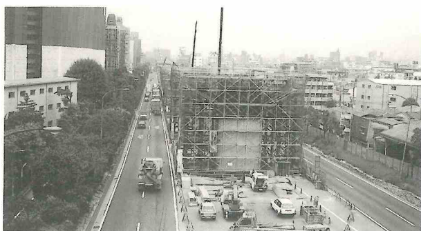
ビルツ区間における橋脚の再構築（阪神高速道路神戸線・神戸市東灘区深江付近）
