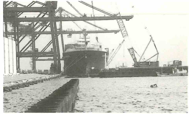
写真-2 復旧工事に隣接して行われている荷役作業
