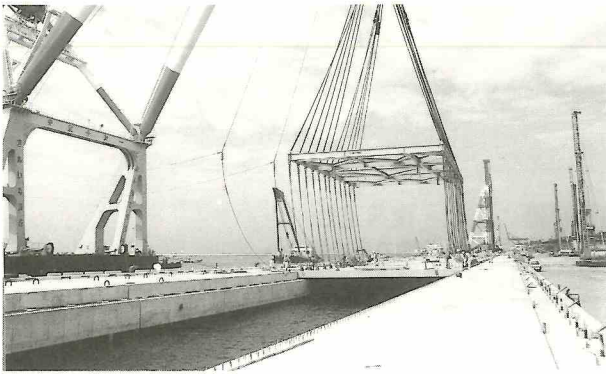
写真-1 岸壁背後を利用したケーソン製作工事
