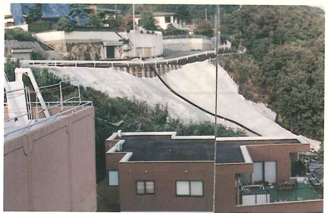
地すべり応急工事(モルタル吹付) 神戸市東灘区西岡本(6頁参照) 写真提供: 兵庫県土木部
