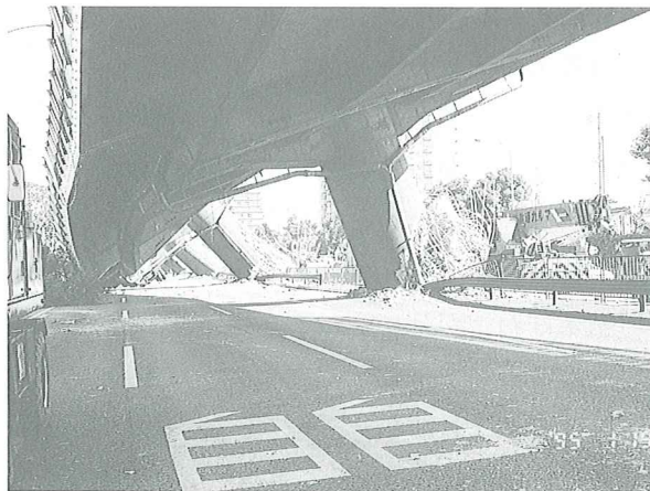
ラーメン柱の破壊例（JR東海道本線）
