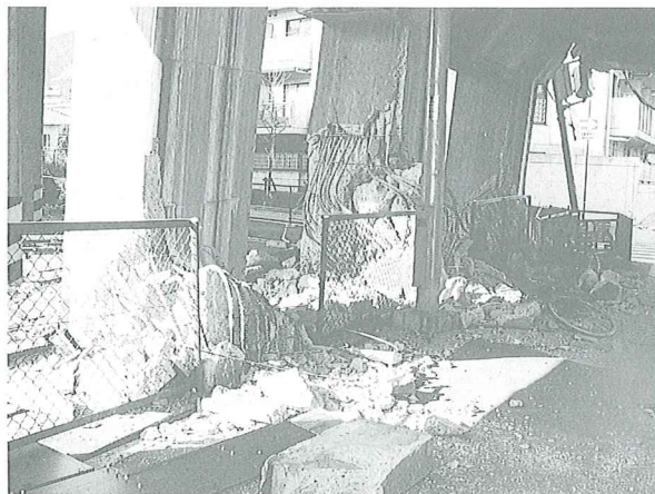
ラーメン柱の破壊例（JR東海道本線）
