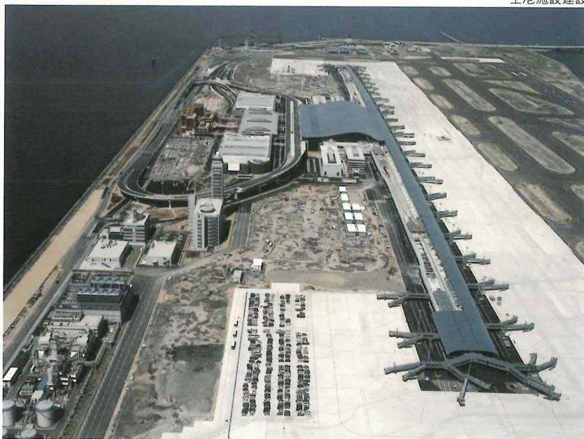
空港施設建設
