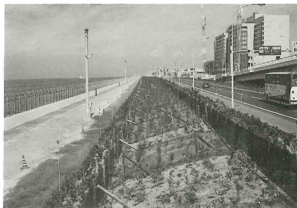
写真-1 エコロジー緑化現況写真
