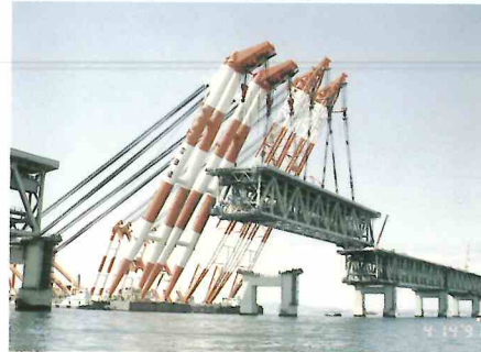
道路・鉄道併用のトラス橋の架設
