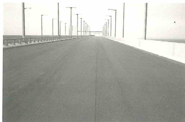
写真-3 ひびわれ防止の縦目地
