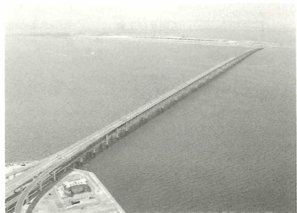
写真-1 連絡橋完成写真
