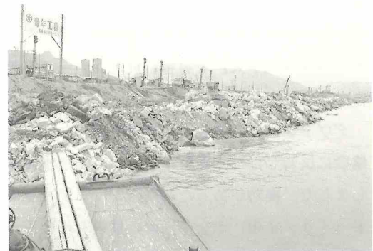
工事が進められているダム建設予定地
