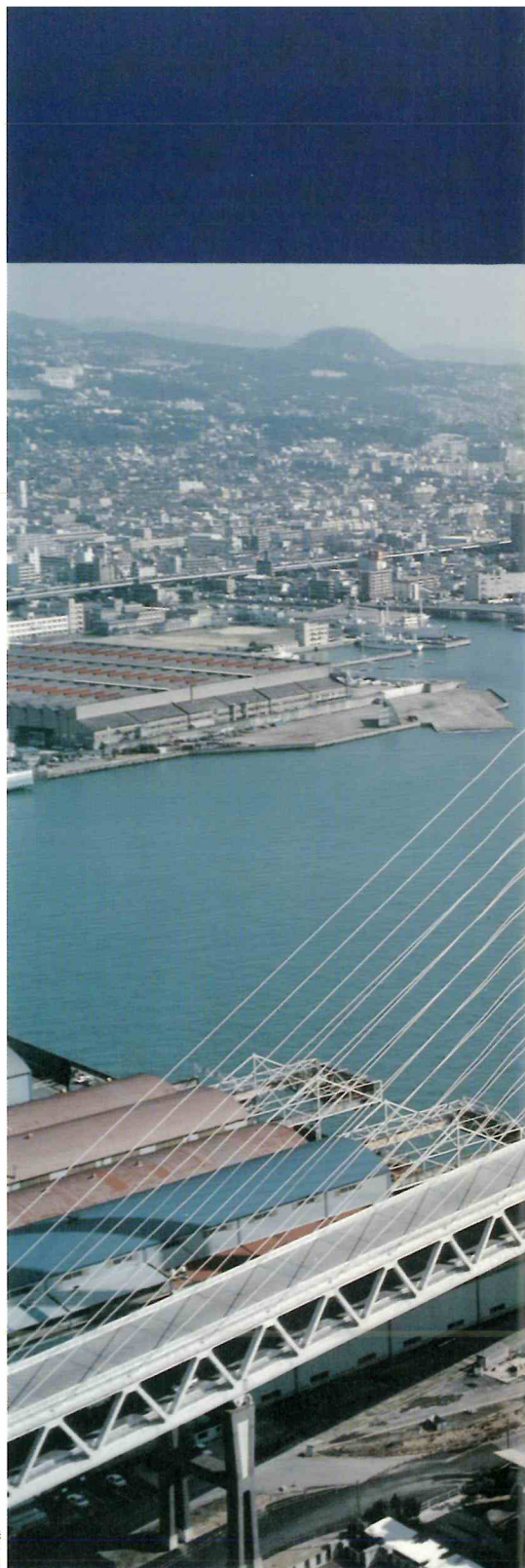
東神戸大橋 (写真提供：阪神高速道路公団)
