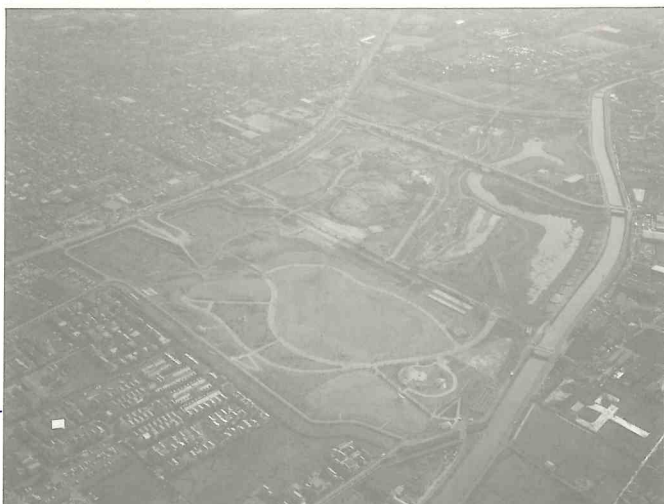
寝屋川遊水池全景
