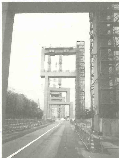
魚崎高架橋基礎工事
