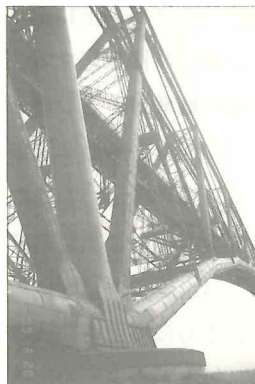
写真2 フォース橋 下から見上げた様子
