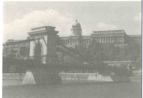
写真-3 ブダペストの象徴、セーチャーニ橋
