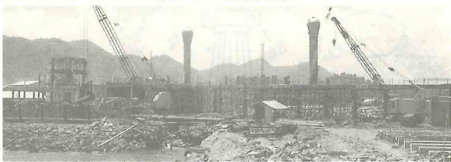
アニエルの化学プラント建設現場
