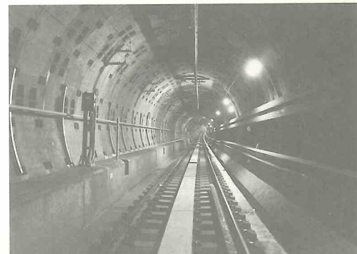
泥水加圧式 シールド (外径5,430mm)
