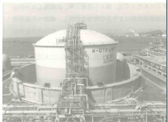
LNG地上式タンクPC防液堤
