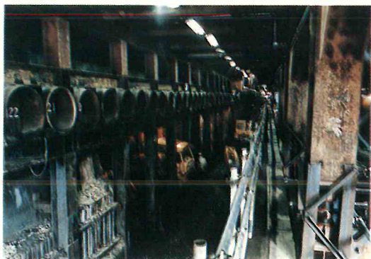
大口径パイプルーフによる仮受け
