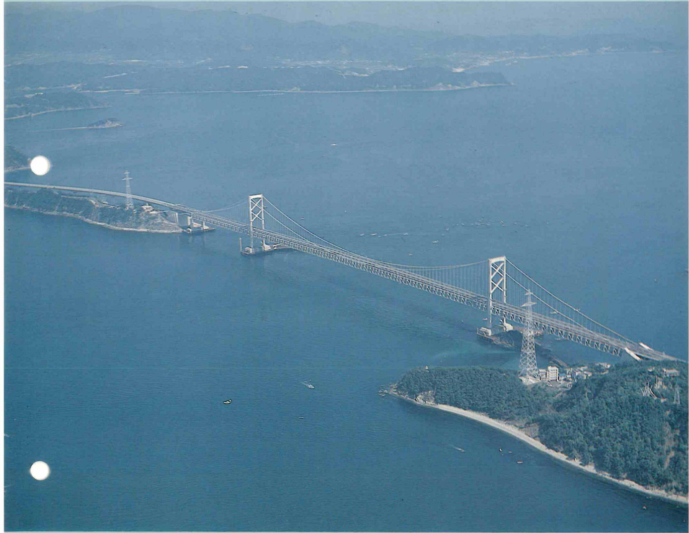
完成した大鳴門橋
