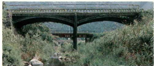
羽瀨鑄鉄橋 (写真提供 兵庫県)
