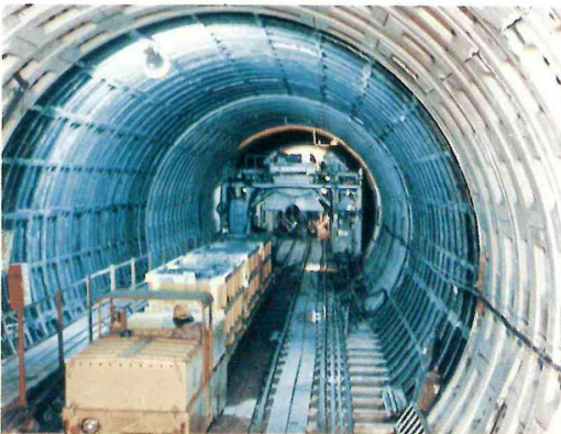
大阪地下鉄4号線大断面土圧式シールド工事
