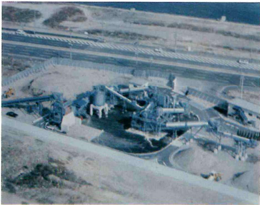
大阪市掘削残土処理プラント
