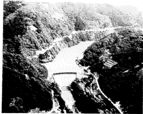
写真-3 小牧ダム
