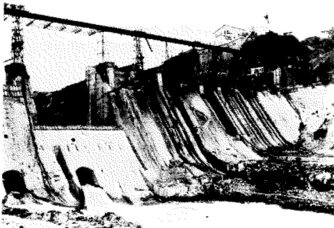
写真-2 工事中の大井ダム
