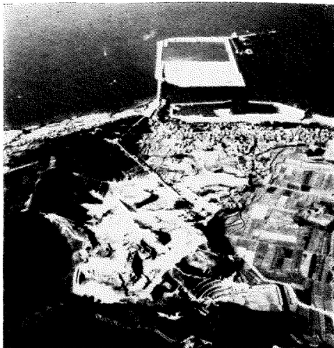
写真-9 御坊発電所・土取場～人工島
