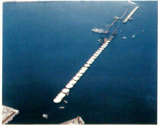
住金・和歌山西防沖根入れ式鋼板セル護岸
