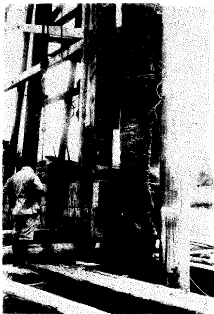
写真-3 確認のため引抜かれたペDESTAL杭 (桜宮橋昭和3年9月)
