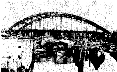
写真-2 架設中の大正橋 (大正4年完成)
