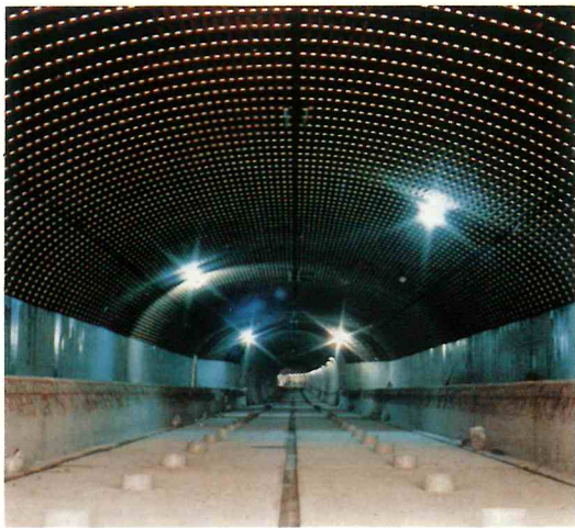
軌道敷設を残すだけとなった福知山線第1武田尾 トンネル大断面区間、宝塚方より福知山方を望む
