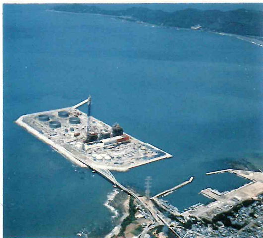
上空より見た御坊火力発電所人工島
