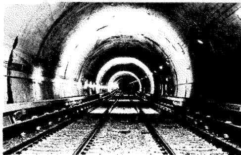
写真-4 川口シールド (完成した複線隧道)
