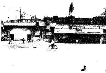
写真1 杭長の相違による不等沈下(北側)
