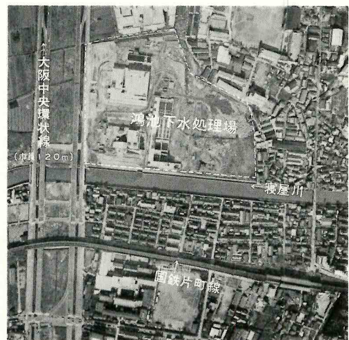
写真-3 鴻池下水処理場
