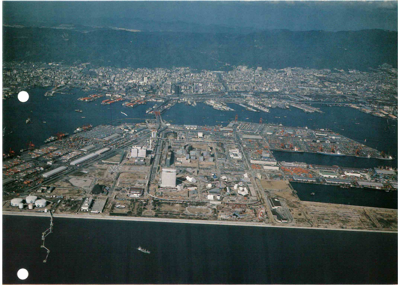
'81 ポートピア会場建設中のポートアイランド全景
