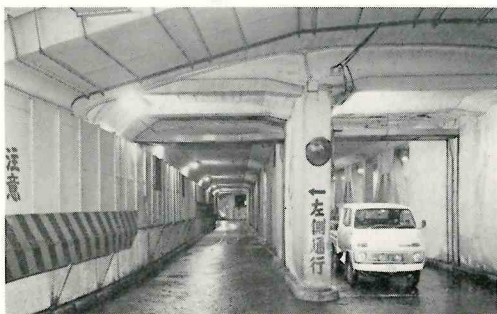
▲安治川河底トンネル (昭19) 日本最初の沈埋トンネルとして昭10着工。ト ンネル全長80m, 両端のエレベーターにより 昇降する。河底部沈埋函は構造上は両端ケー ソンに支持された橋梁。(L=49.2m)
