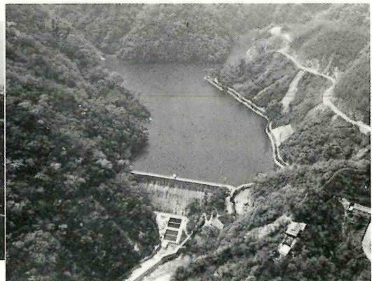
▲神戸・五本松ダム(通称布引ダム) (明33) わが国最初のコンクリートダムで上水道用, 高33.3m。
