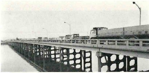
▲大阪・神崎橋 (昭28) 日本最初の合成桁橋 (スパン11.5m, 橋長320m)
