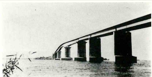
▲琵琶湖大橋 (昭39) 日本最長スパン(140m)のけた橋であった。現在は関西で、第2摩耶大橋(210m)、千本松橋(150m)につぐ。
