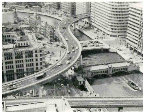
▲阪神高速道路 中之島S字橋 (昭39) S字型の3径間連続鋼床版箱桁橋として世界最初のもの。
