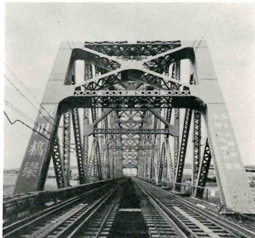
▲近鉄 よど 澱川橋梁 (昭3) 複線下路Kトラス橋, 現在も鉄道橋ではわが国 最長スパン164m.
