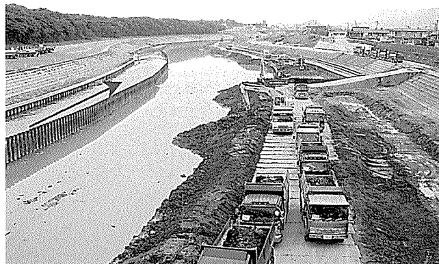
右岸側掘削状況
