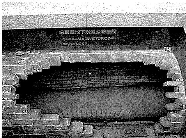
旧神戸外国人居留地 下水渠
