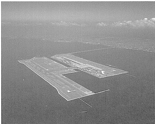
2007年8月供用開始した関西国際空港第2滑走路
