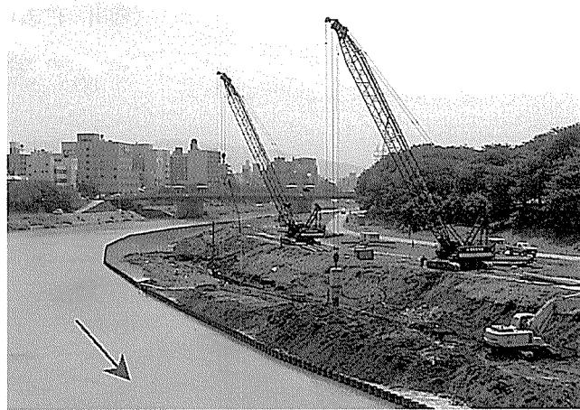
左岸側掘削状況
