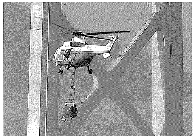
図-3 ヘリコプターによるパイロットロープ架設
