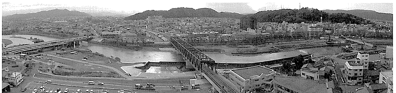
橋梁工事状況
