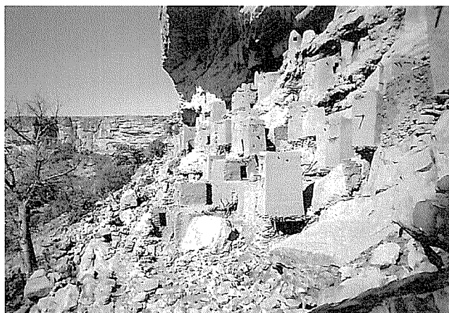
写真-1 アフリカ・マリ共和国ドゴン族の村 (崖斜面上の日干し煉瓦と泥の家)
