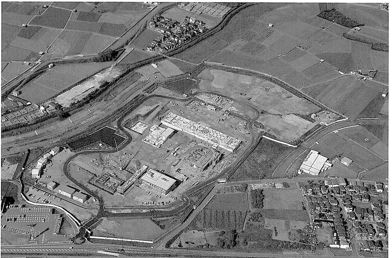
那賀浄化センター
