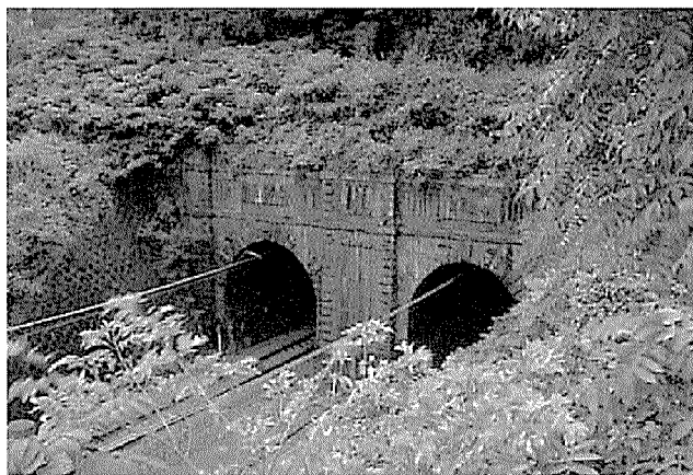
東山・新逢坂山トンネル
