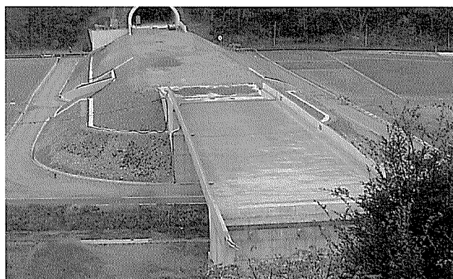
七坂トンネル・居組大橋
