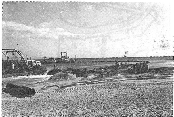
写真 6.5 バージアンローダによる養浜
