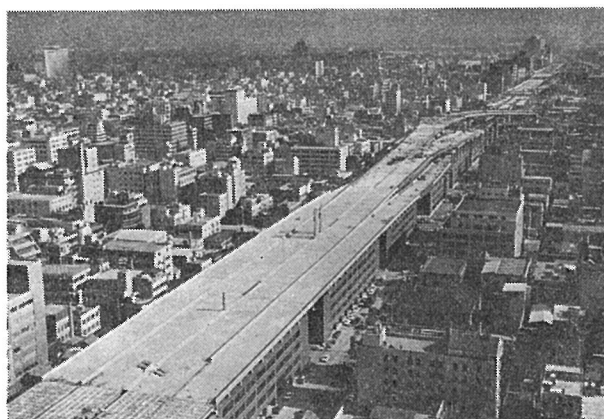
写真2.8 船場再開発ビルと高速道路
