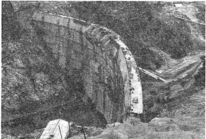
写真7.3 本体打設概成(昭和51年5月)
