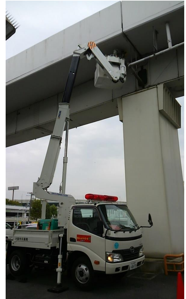
当社所有の高所作業車 による点検 (高架部)
