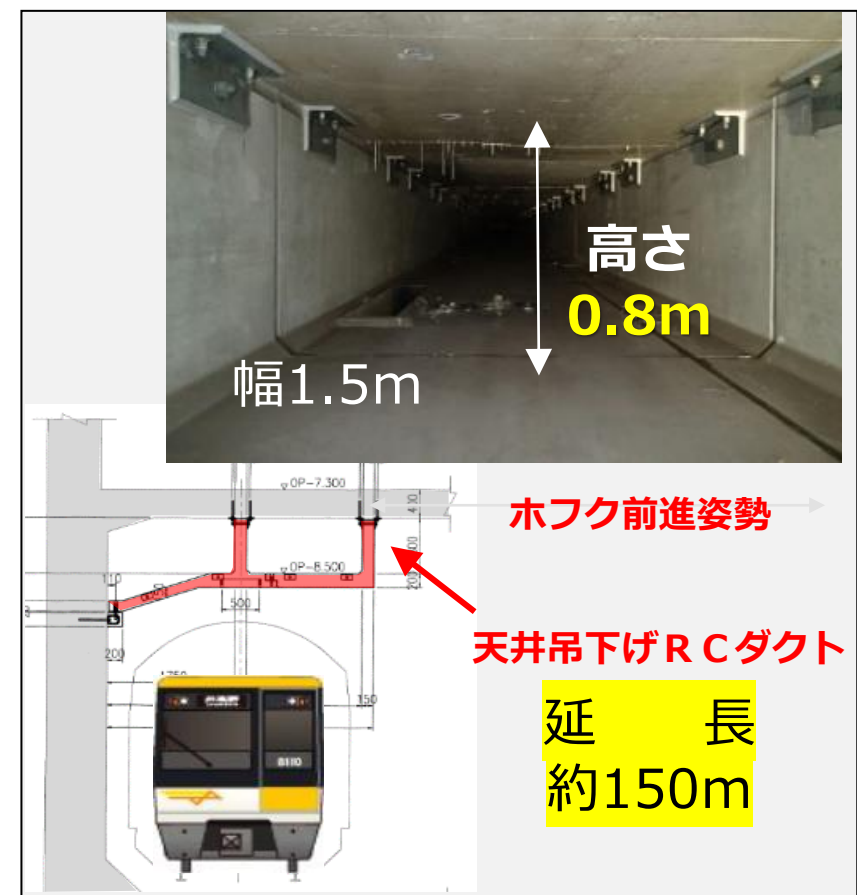
軌道直上のRCダクト 吊下げ樹脂アンカー
