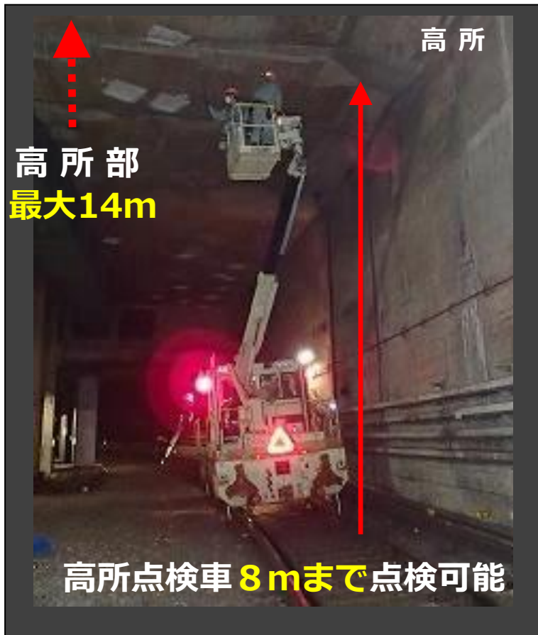
シールド立坑等 トンネル高所部
