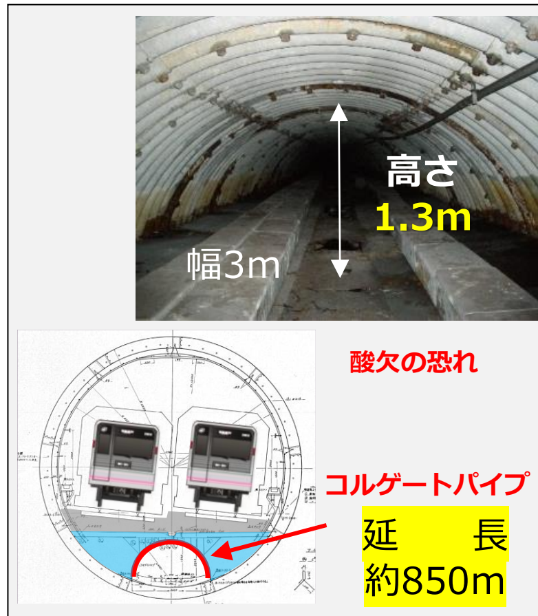
複線シールド道床下 コルゲートパイプ
