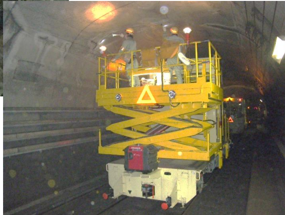
当社所有の構築点検車 による点検 (地下トンネル内・営業終了後)
