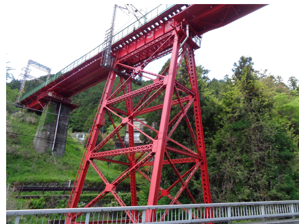
トレスル橋（東京都青梅線奥沢橋梁）
