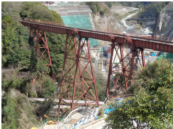
トレスル橋（熊本県立野橋梁）
