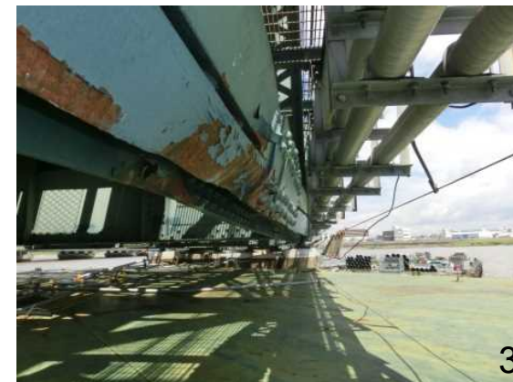
異常出水で花火大会用の台船が漂流しトラス桁に衝突した事故(2014.8.12)下弦材が損傷し部材ごと取り換えた
