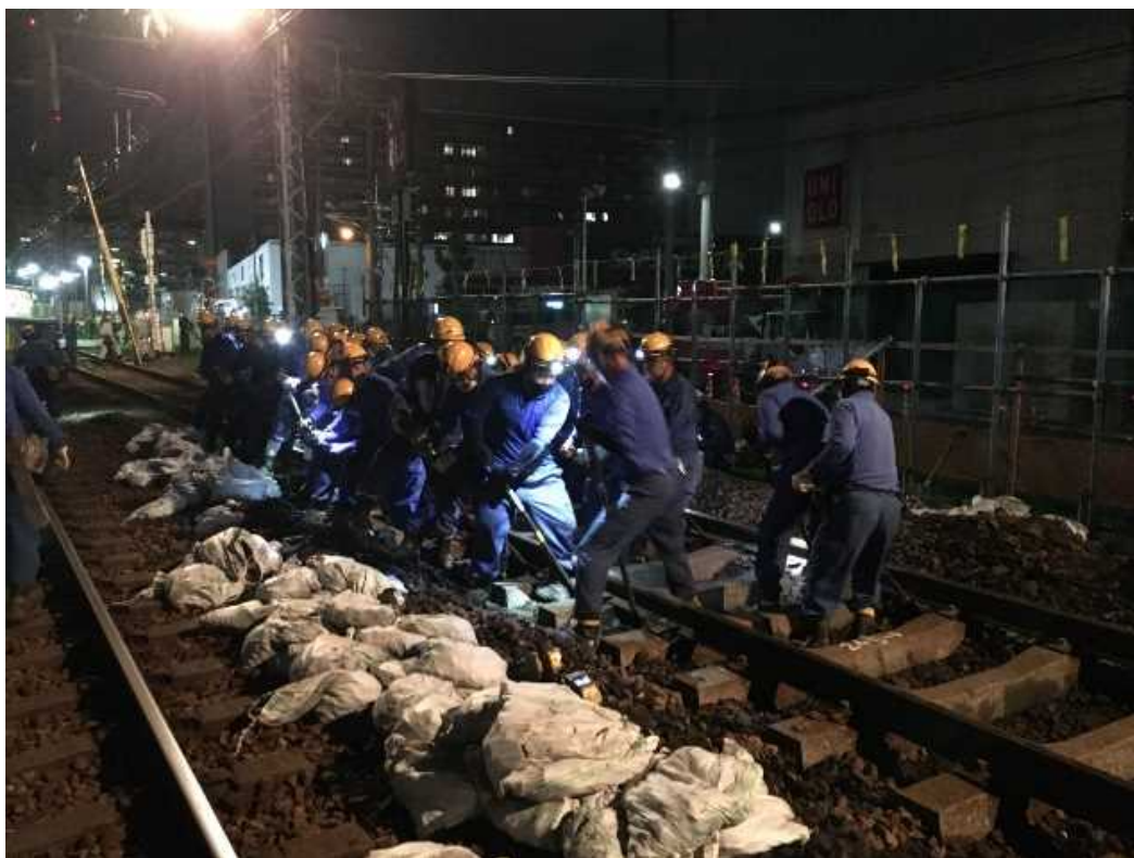
＜線路切替状況(陸上部)＞
