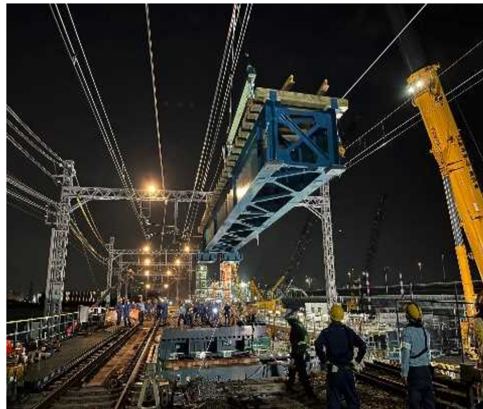
＜仮下り線桁架設状況(橋梁部)＞
