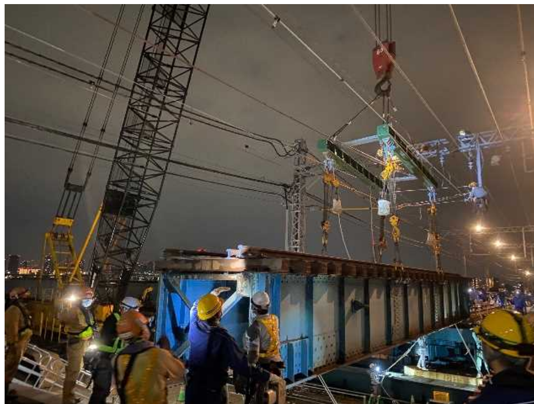
＜線路切替状況(橋梁部)＞
