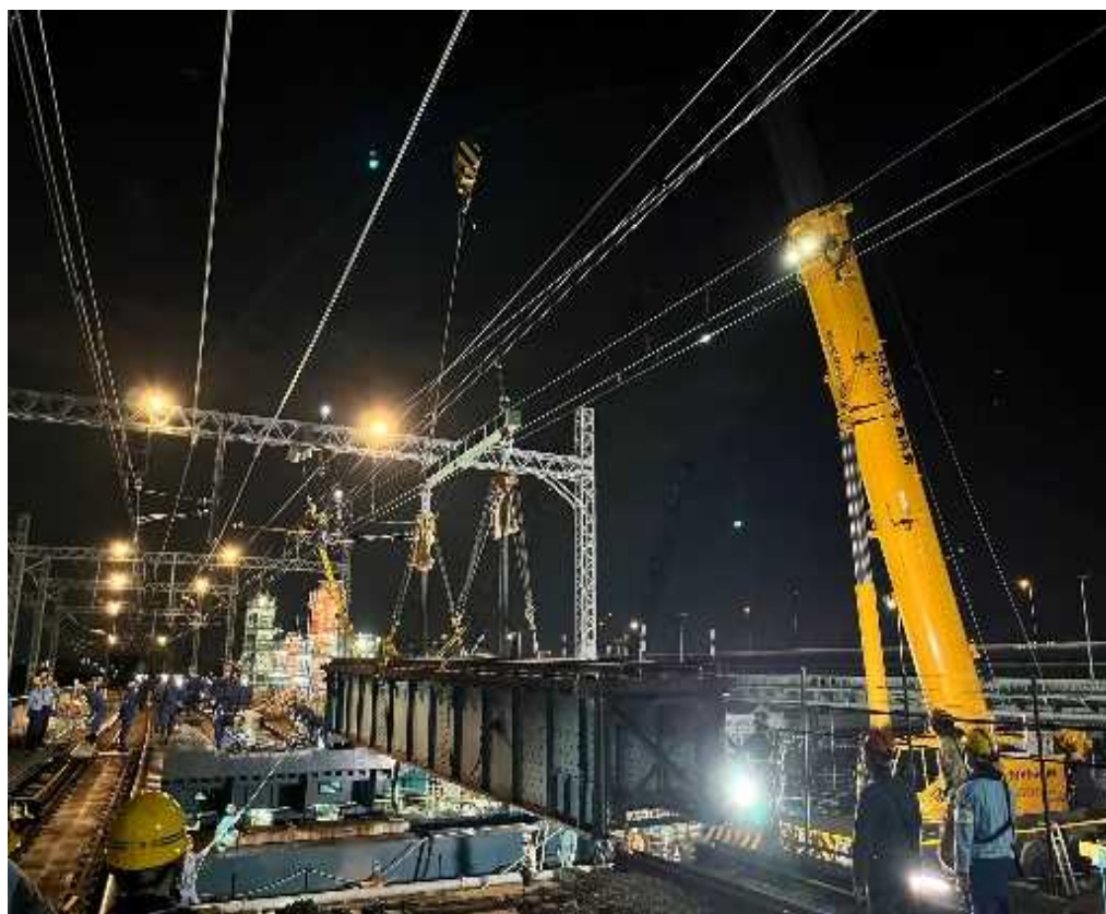
＜現在下り線桁撤去状況(橋梁部)＞
