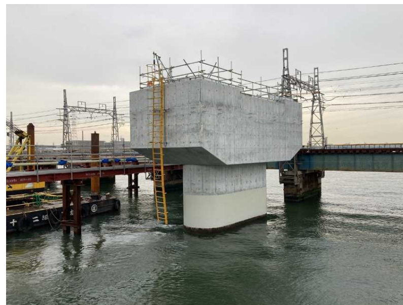
④ P58場所打杭基礎工（フーチング基礎構築）
