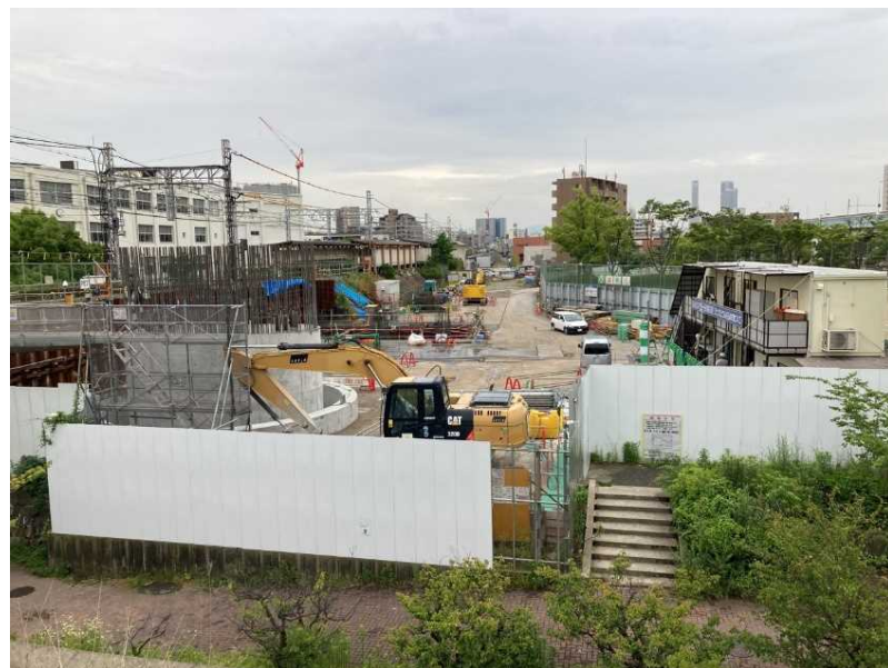
③ P57オープンケーソン基礎工（橋脚構築）
