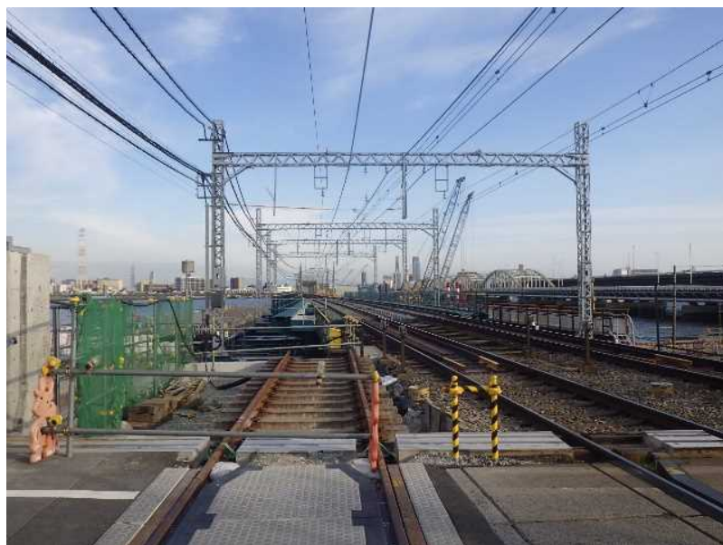
＜切替前(橋梁部)＞
