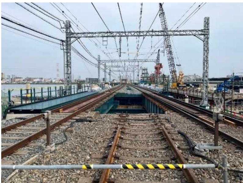
＜切替前(橋梁部)＞
