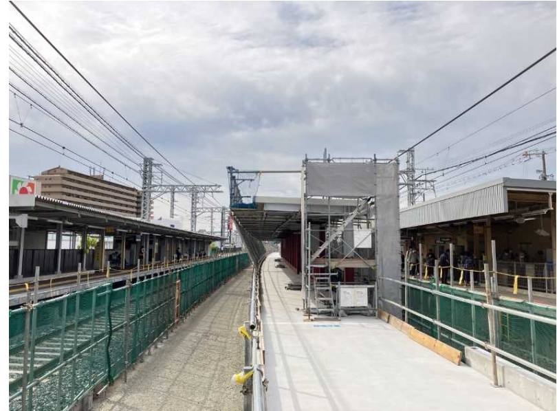
②仮駅舎構築工（屋根、外壁設置）
