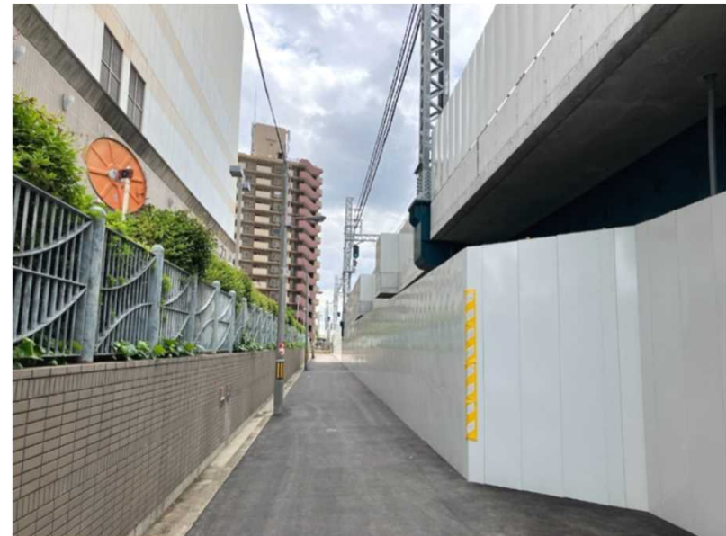
②側道復旧工（環境事業センター前）
