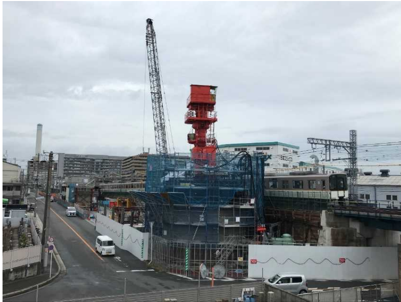
① P46ニューマツケトン基礎工 (9R鉄筋組立)
