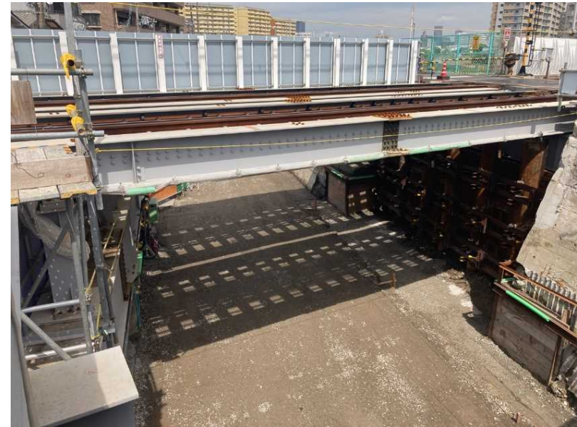
②既設橋台撤去工
