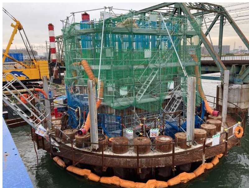
③ P57オープンケーソン基礎工（橋脚構築）
