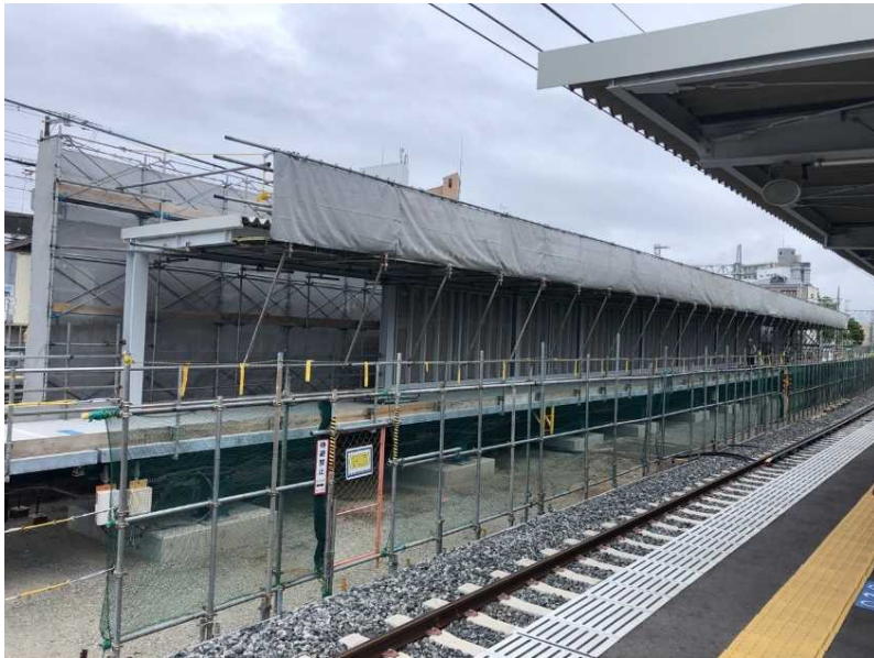
③仮駅舎構築工（屋根、外壁設置）
