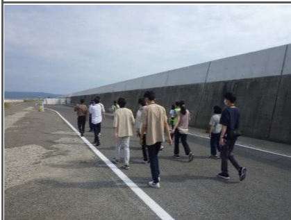
▼南側の護岸において沈下量や護岸の嵩上げ量を目でご確認いただきました。
