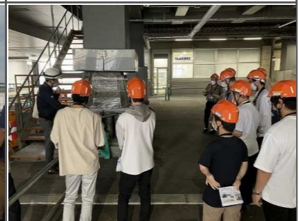
▼ジャッキアップされた柱を見学いただきました。
