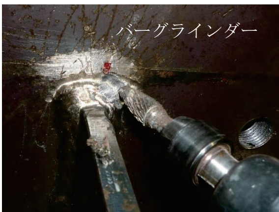
写真-10 C断面ステップ3(1), バークラインダーを用いた切削状況
