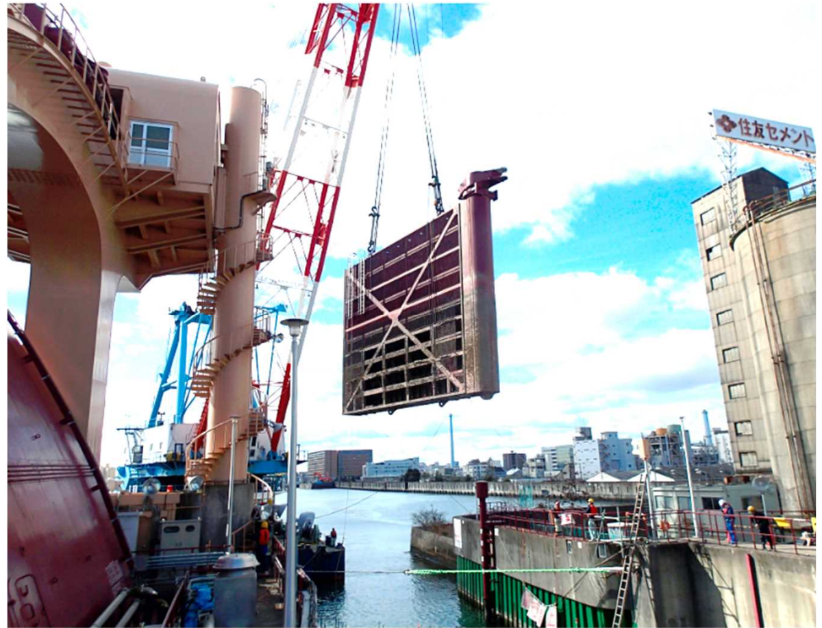
安治川 扉体撤去
