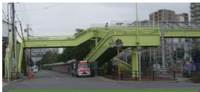
日之出跨線橋
