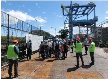
8. 第2工区の現場見学では、直上施工の方法について説明がありました。
