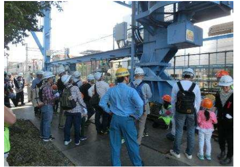
9. 強風で上には上がれませんでした。が、風速を監視しながら、安全に工事を進めていることを学びました。
