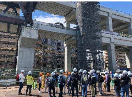
10. 第3工区の現場見学では、重さ1,300tもあるトラス橋を見学しました。
