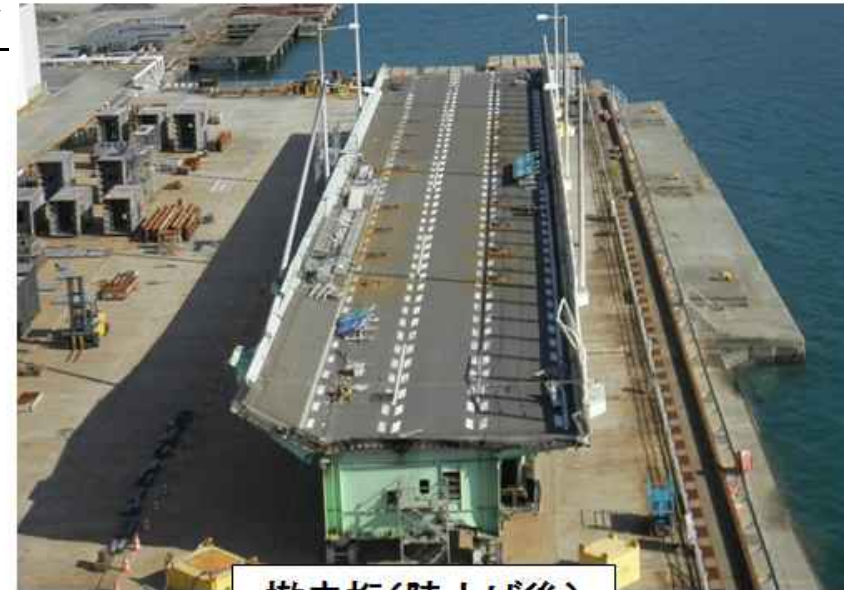
撤去桁(陸上げ後)
