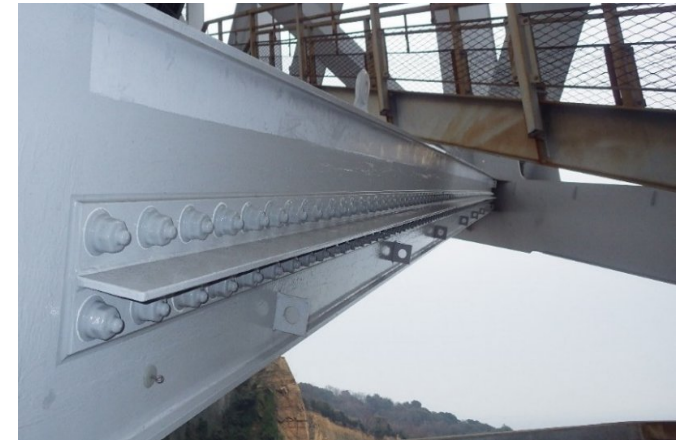
高力ボルトによる補強部材設置例
