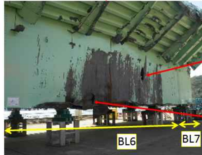
ウェブ破断、変形
