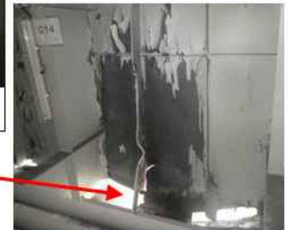
ウェブ破断、変形
