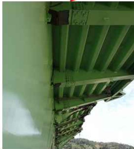
ブラケット破断変形
