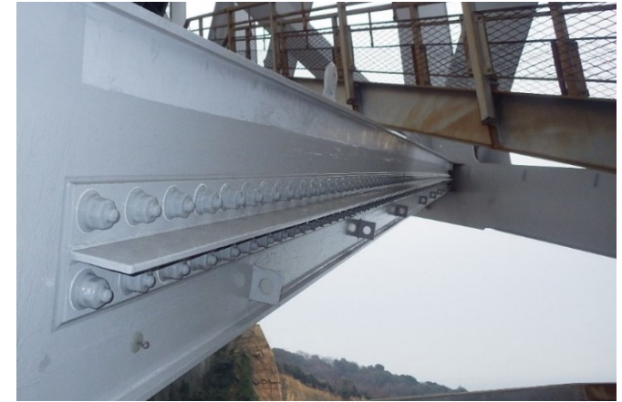
高力ボルトによる補強部材設置例
