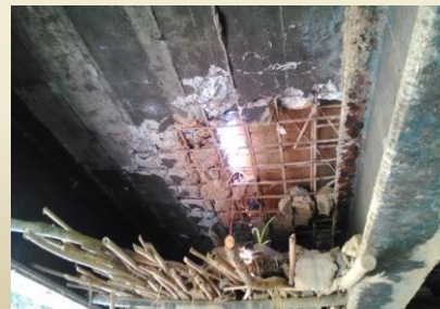
過積載とコンクリートの低品質・鉄筋不足のため抜け落ち
