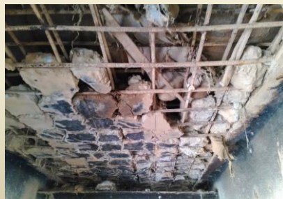
過積載とコンクリートの低品質・鉄筋不足のため抜け落ち
