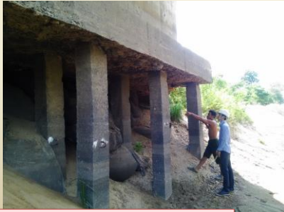
橋台や橋脚の洗掘
