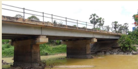
鋼桁橋は形鋼を定尺以下で使用するのが大多数（ボルト接合はほとんどない）
