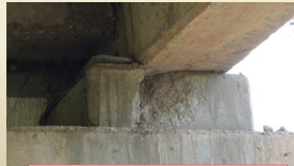
桁の直置き(支承がない)
