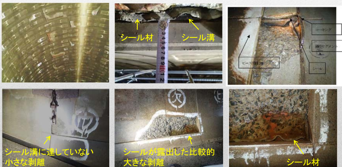
※上段：外郭放水路（左と中：第3工区、右：第2工区）、下段：環七地下調節池
