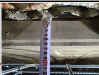
シール材が露出する剥離
