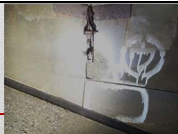
比較的浅い軽微な剥離
