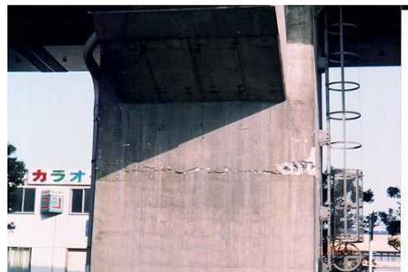
写真1.1 橋脚部に水平面上に生じた亀裂
