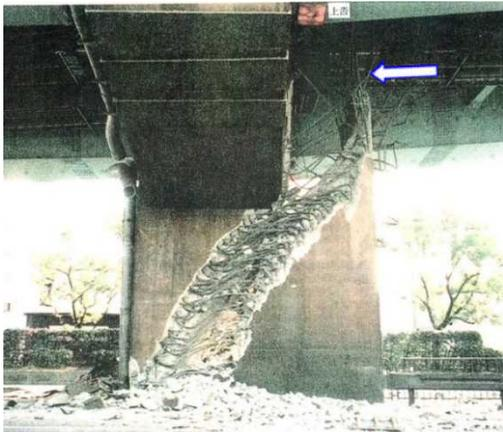
図 1.48(a) P240 柱の崩壊,柱の裸鉄筋の直立<sup>25)</sup>
