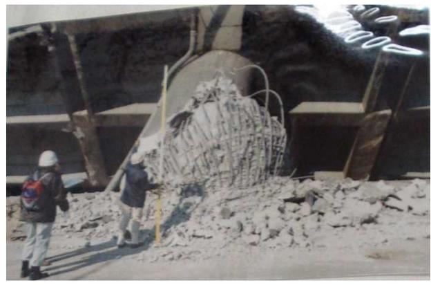
・コンクリートの破壊面に沿い鉄筋のクビレが分布・北東—南西方向に割れが発達・北西部に落下の痕跡
