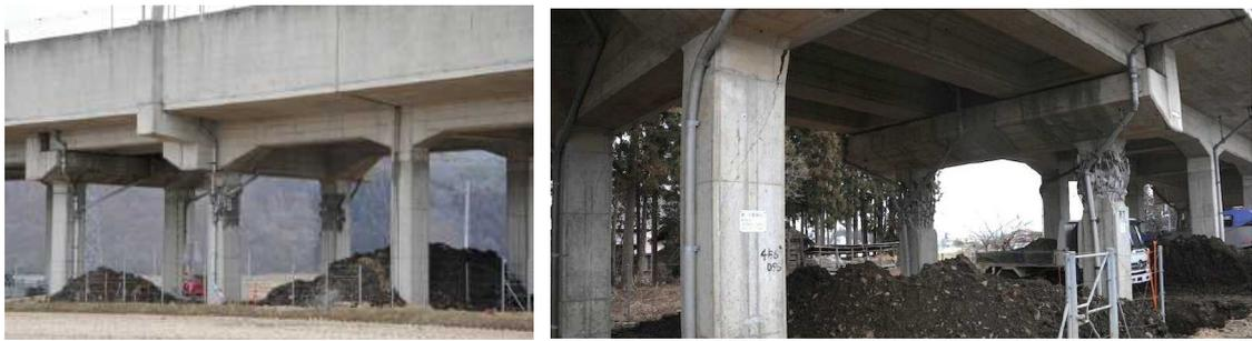
(a) R6 橋から R7 橋端部の外観 (b) R6 橋-端橋脚の頭部は斜亀裂,R7 橋-端橋脚の頭部が破壊
