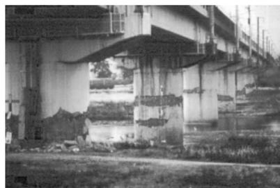
写真 5 引張・圧縮複合破壊 (楕円断面柱)
