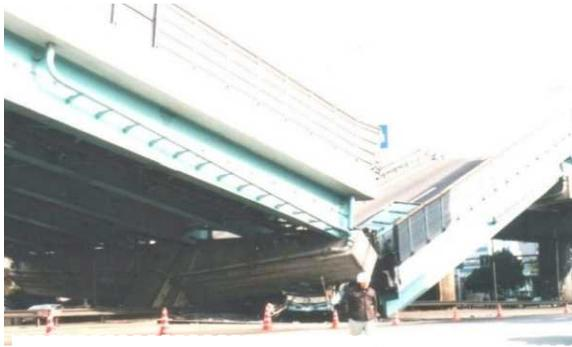
図 1.50 西 P167 の崩落状況
