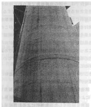
写真 1, 2 水平輪切りひび割れ (円柱, 角柱)
