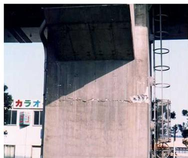
写真 1.1 鉄筋コンクリート橋の橋脚部に水平面上に生じた亀裂
