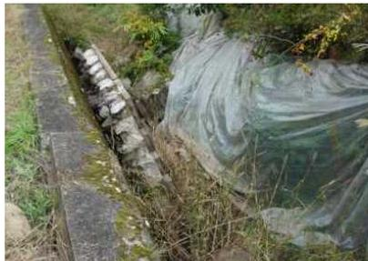
右の護岸壁が反転して左護岸側に
