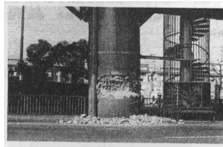
写真 3 引張・圧縮複合損傷 (円柱)
