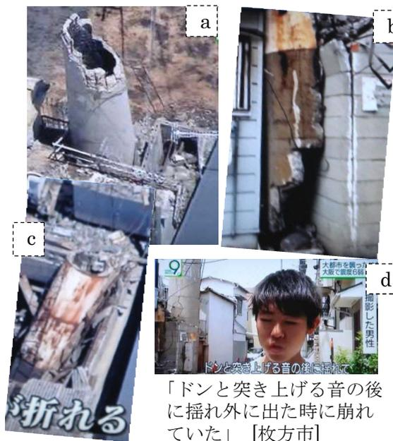
図 1.102 煙突三分割破壊と証言<sup>56</sup>
