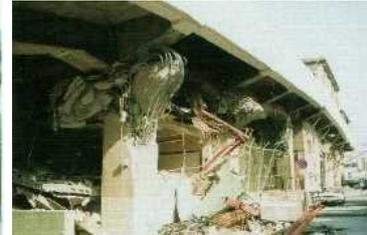
下層柱が崩壊-その位置に崩落 図 1.70 新幹線 阪水高架橋<sup>32)</sup> マッシュルーム型破壊 図 1.71 JR 六甲道駅東付近<sup>32)</sup> 柱頭部の破壊状況 図 1.72 阪神-石屋川車両基地<sup>32)</sup>
