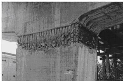
写真 4 引張・圧縮複合破壊 (角柱)
