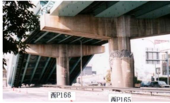
図 1.51 西 P166(極軽傷)と西 P165(圧縮破壊)の状況
