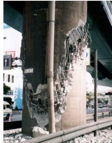
図 1.52 西 P165 圧縮破壊部
