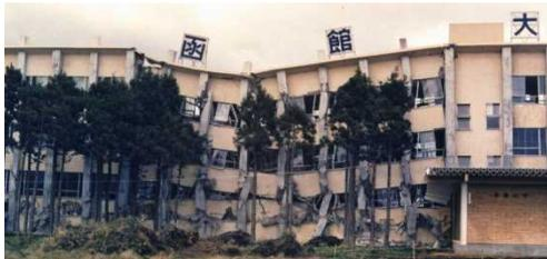
8パネル間の柱の4階全層破<sup>63)</sup>
