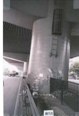
図 1.30 P58 柱基部の曲げ損傷状況<sup>26)</sup>
