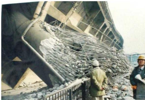
・北東から南西方向に割れが発達・北西部に落下の痕跡
