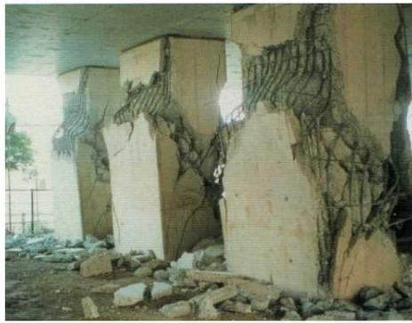
橋脚の軸圧縮破壊(宝塚高架橋)
