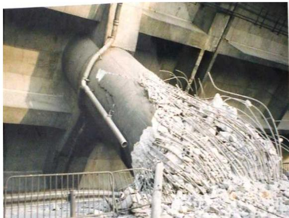
・柱の南西面に大きな斜め割裂塊,
