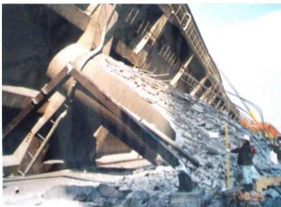
図 1.34 倒壊橋脚の代表例 P132(西面)<sup>29)</sup>
