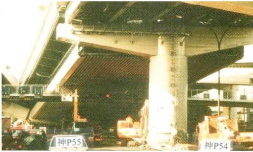
図 1.27 P54 柱基部の曲げ破壊状況<sup>25)</sup>
