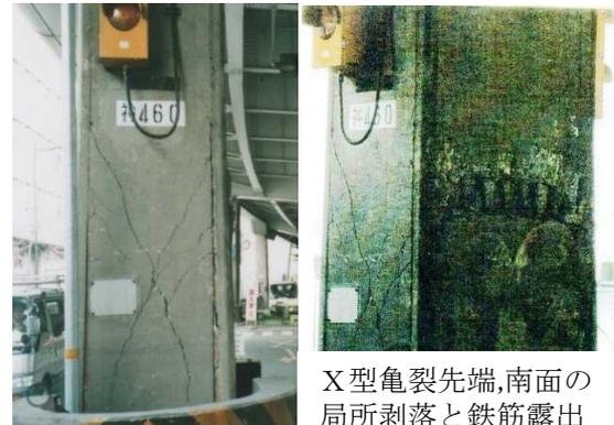
X 型亀裂先端、南面の局所剥落と鉄筋露出
