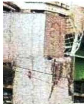
図 1.12 P455 山側柱頭部の損傷状況<sup>22)</sup>
