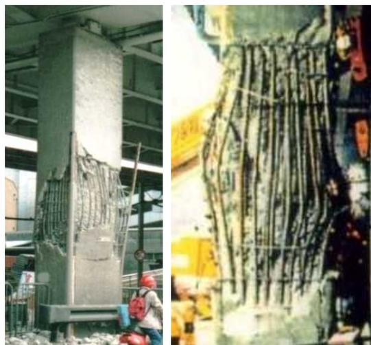
(a)被災時の姿<sup>26)</sup> (b)浮きコンクリ剥離時<sup>23)</sup>
