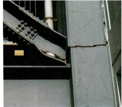
(極厚鉄骨柱の破断)
