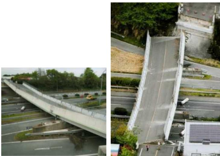
(a) 脚柱異常散乱と横移動<sup>50)</sup> (b) 橋台部の異常落下痕<sup>51)</sup>
