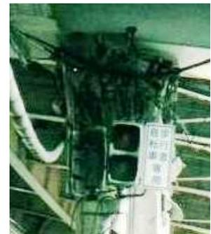
図 1.14 P459 海側柱頭部の破壊状況<sup>23)</sup>
