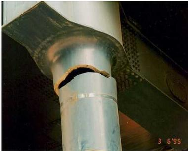
写真 1.2 鋼製橋脚の橋脚上部に生じた脆性的な破壊
