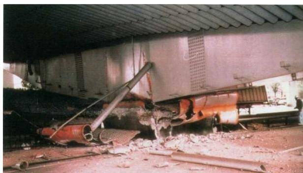
水平位置が変わらず崩落-柱が挫滅
