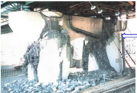
図 1.49(a) P688 柱の崩壊,柱の裸鉄筋の直立<sup>25)</sup>
