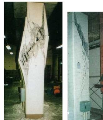
(a)柱の亀裂<sup>27)</sup> (b)逆くの字<sup>32)</sup> 図 1.76 神戸地下鉄上沢駅
