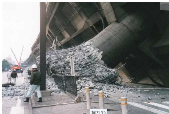
・基部の鉄筋が南側にも湾曲, コンクリートの破壊線が柱軸線に直角, 基部の鉄筋は東西共外側に大きく湾曲
