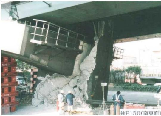
図 1.47(a) P150 柱の崩壊,柱の裸鉄筋の直立<sup>26)</sup>
