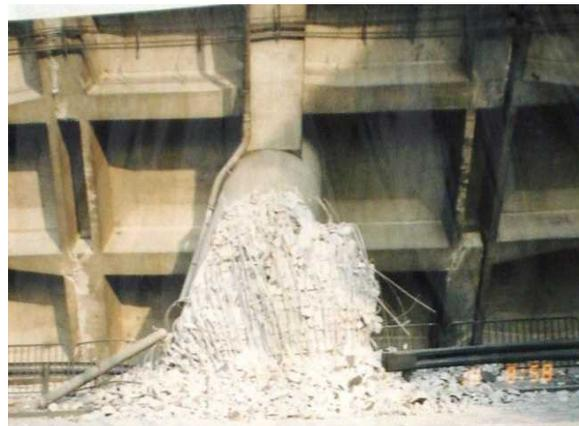
・柱基部は北西側に着地,北東から南西方向に割れが発達
