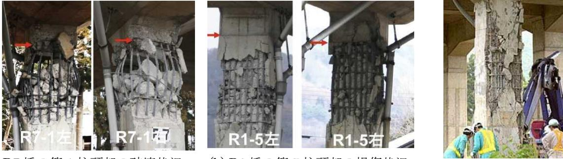
(a) R7 橋の第 1 柱頭部の破壊状況 (b) R1 橋の第 5 柱頭部の損傷状況
