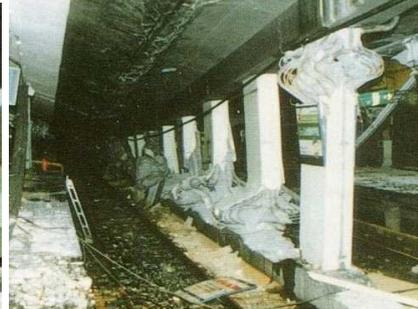
1層の柱が崩壊 図 1.73 阪急-伊丹駅被災状況<sup>32)</sup> 図 1.74 神戸高速鉄道<sup>32)</sup> 中柱の崩壊 図 1.75 神戸地下鉄大開駅<sup>27)</sup>
