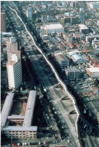
図 1.32 ピルツ橋倒壊区間の全景<sup>27)</sup>
