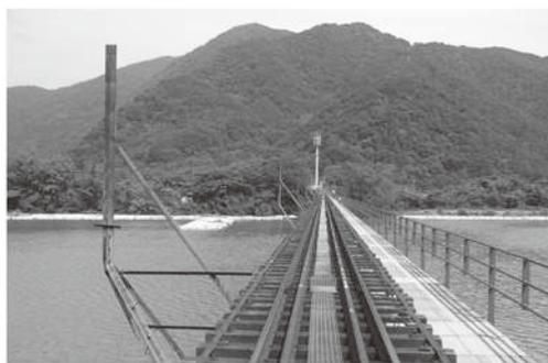
写真4 木製枕木とレール(下流側に国鉄時代の通信線の支柱が残されている)
