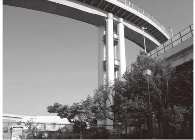
写真3 鋼管集成橋脚（海老江JCT）
