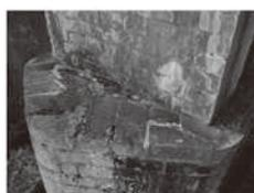
写真4 薬水拱橋 水切りで使用される異形煉瓦
