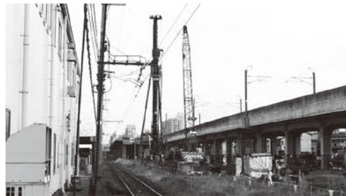
写真1 仮線工事状況(杭打ち時)
