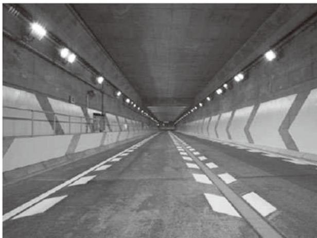
写真2 正蓮寺川トンネル（速度抑制効果を期待した壁面デザイン）
