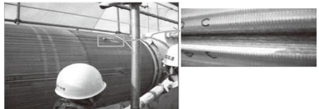
写真1 主ケーブルを開放して点検している状況
