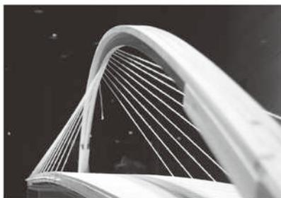
写真6 断面のアーチとケーブル定着部
