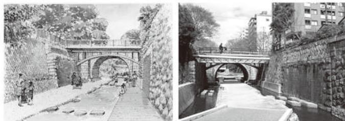
「堀川水辺環境整備構想」における堀川第一橋下流側のイメージパース(左)と実際の整備状況(右)。手前の煉瓦壁はチンチン電車橋台跡
