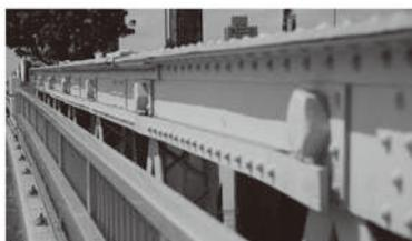
トラス上弦材の様子。斜材を留めるボルトとリベットが規則正しく並んでいる
