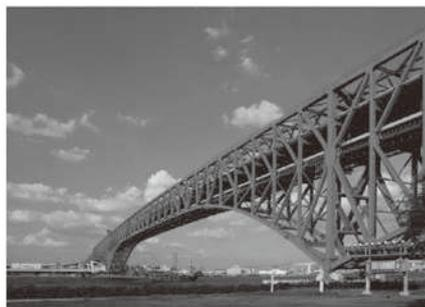
写真4 免震・制震機構による地震対策を施した港大橋
