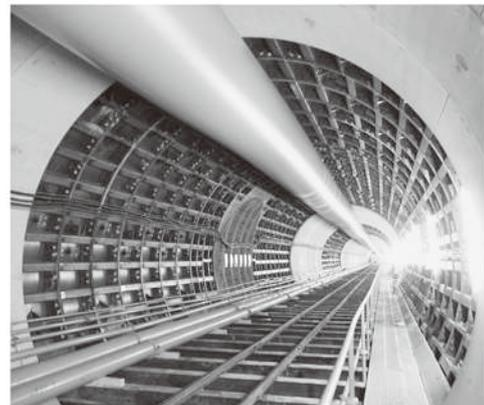
■北浜逢阪貯留管の施工状況(直接切削セグメント部)
