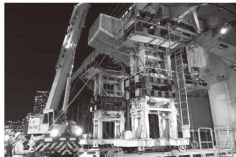
■軌条設備上に自走式油圧ジャッキ架台を組み立て、切断したRC橋脚梁ブロックを空頭制限を受けない桁外側まで引き出している状況
