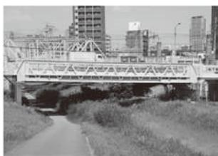
下流側からみた浜中津橋。十三小橋から転用された桁台からコンクリート橋台に変更し橋を改造して延長した様子がわかる
