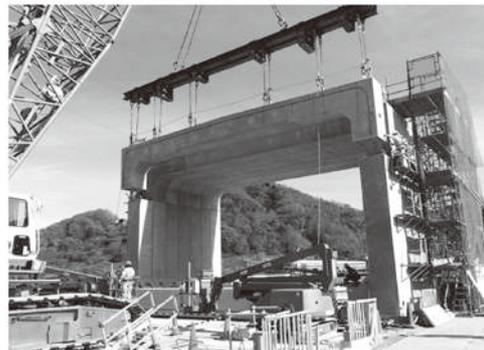
■専用吊具(バランスビーム)による上部材の据付状況
