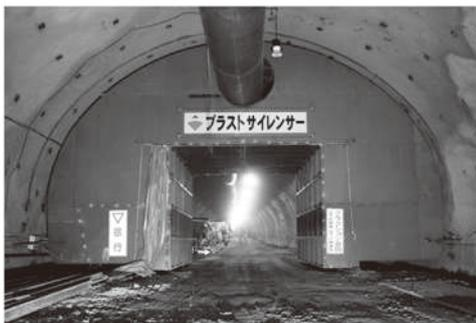
■トンネル発破低周波音消音器
