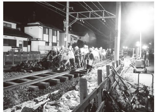
写真2 仮線切替中の状況（レール移動）
