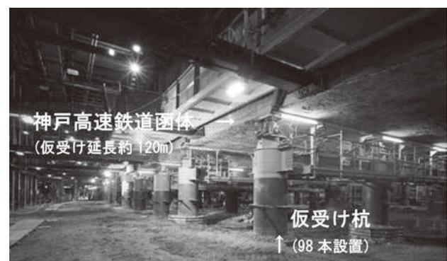
写真6 神戸高速鉄道函体仮受け状況
