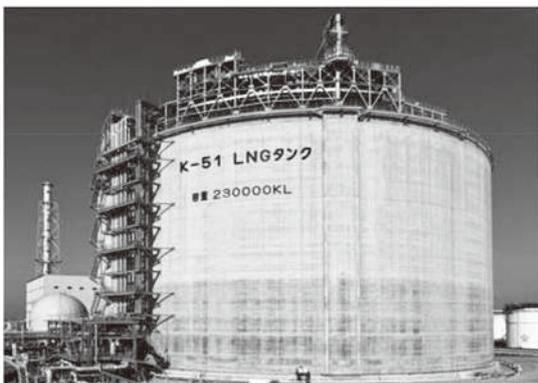
写真1 建設したPCLNGタンク外観
