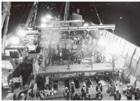
■高速道路で初めてとなる夜間施工・昼間開放による施工条件下での床版取替状況
