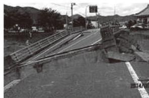
図8 八日市橋の落橋状況(8月21日)
