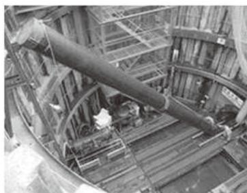
写真2 シールドトンネルへのガス管搬入
