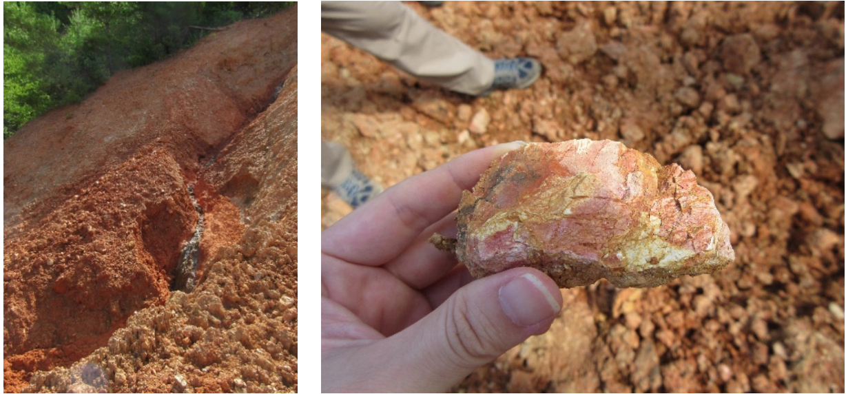
図 10 崩壊土砂と基盤岩盤を流れる湧水（左），崩壊土砂片（右）
