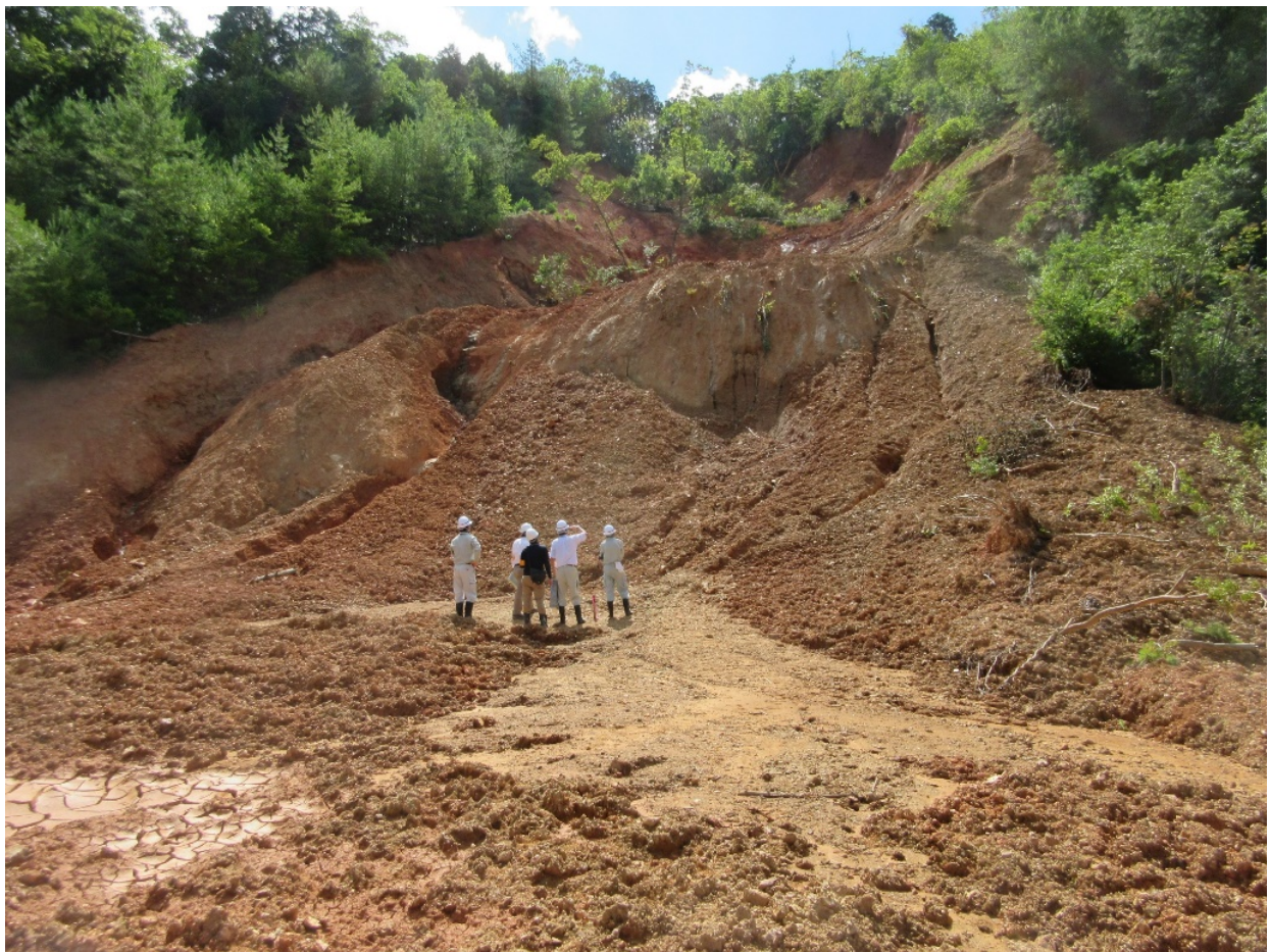
図9 斜面崩壊主要部
