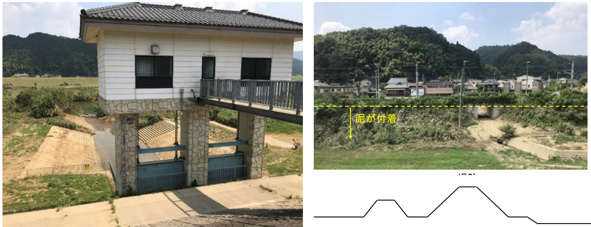
図6 本川と支流の樋門（左），鉄道盛土の浸水深さ（右）
