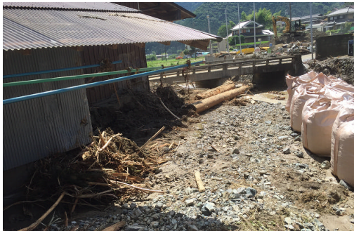
写真3 左岸側家屋の浸水被害 (2018.7.13河原田地区)
