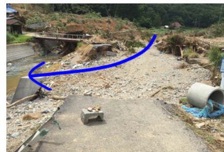
写真18 左岸側の迂回流の流下痕跡(2018.7.13公文地区)
