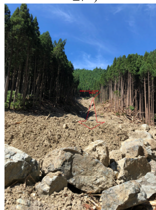
写真13 斜面崩壊 (2018.8.08河原田地区)
