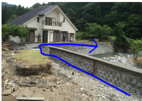
写真20 左岸側迂回流の流路と残された河川護岸（2018.7.13公文地区）
