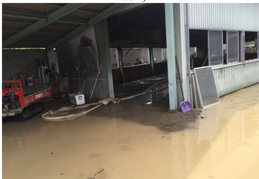
写真7 右岸側家屋の浸水被害(2018.7.13河原田地区)
