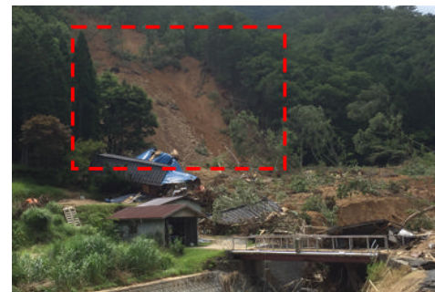
写真16 斜面崩壊による家屋倒壊(2018.7.13公文地区)
