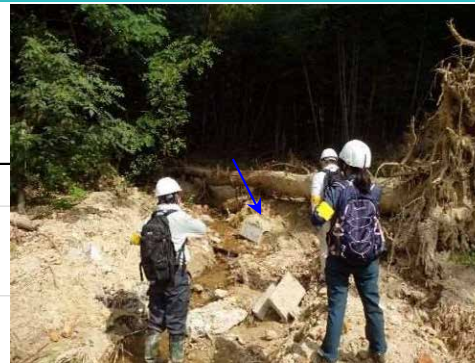
写真-1 砂防堰堤で捕捉された流木
