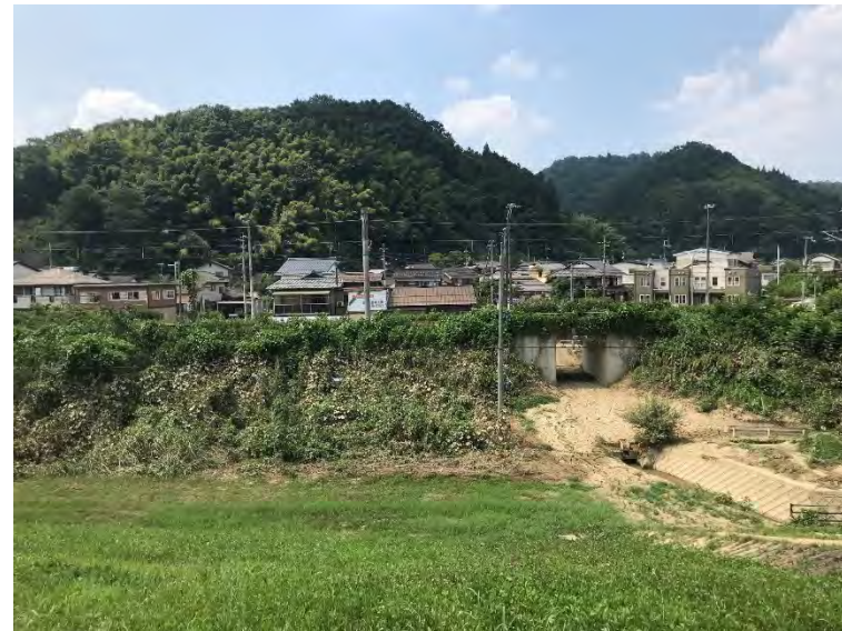
浸水深さと住宅
