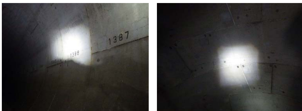
図-2.2.4 北島調節池（コンクリート中詰合成セグメント(HCCPセグメント)）の現地状況
