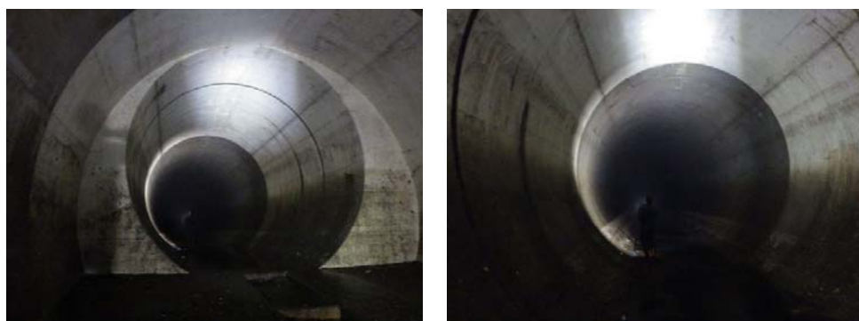
図-2.2.3 古川調節池と北島調節池接続部（古川調側から北島調を撮影）
