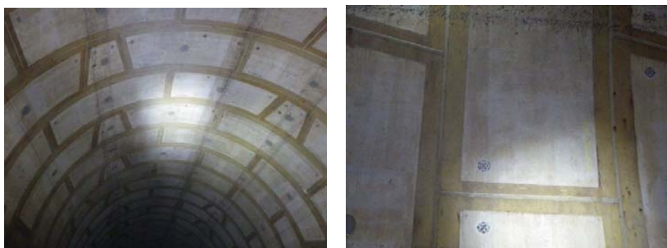
図-2.2.2 古川調節池（NMセグメント）の現地状況
