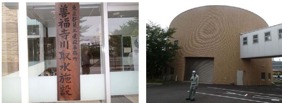
写真-2.1.1 善福寺取水施設の建屋入口（左）と昇降用立坑（右）
