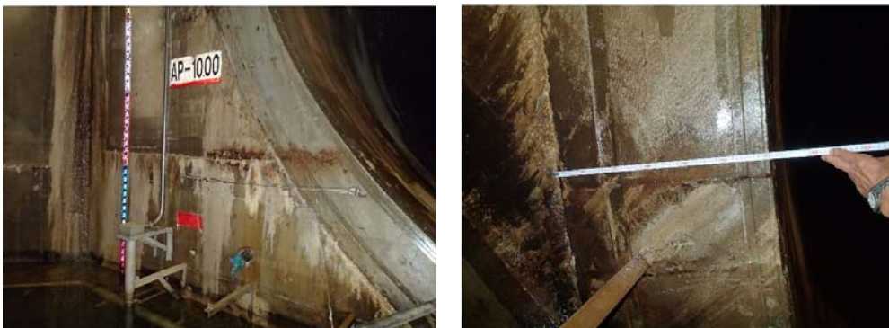
写真-2.1.8 第一期と梅里立坑の接合部（左）とRCセグメントの断面（右）
