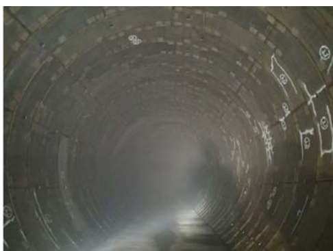
写真-2.1.4 第一期（左：RCセグメント）と第二期（右：合成セグメント）の本管内部
