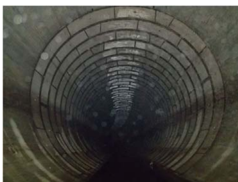
写真-2.1.4 第一期（左：RCセグメント）と第二期（右：合成セグメント）の本管内部
