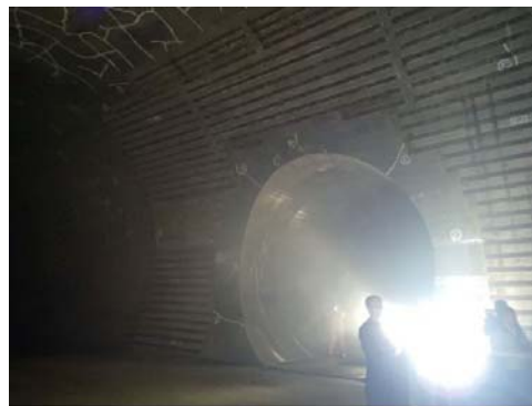
写真-2.1.3 連結管（コンクリート中詰め鋼製セグメント）の内部（右）と本管との接合部（左）
