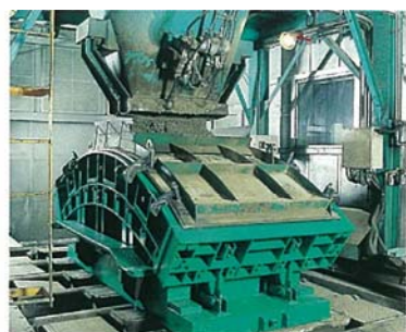
コンクリート投入
