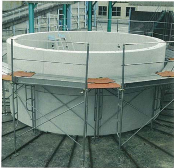
図-2.5.6 セグメントリング水平仮組試験状況 1)
